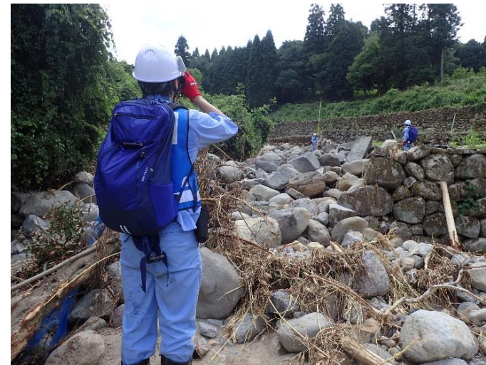
▲7月16日赤迫川(朝倉市) 被災状況調査 【河川 第2班】
