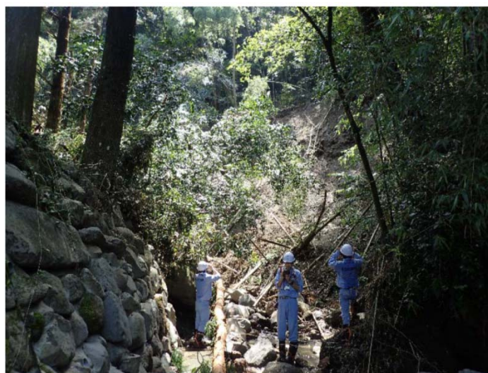
▲ 赤迫川（朝倉市）被災状況調査
