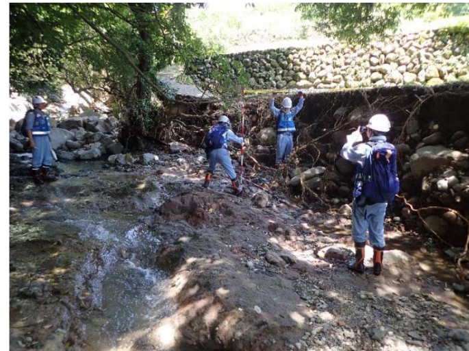
▲ 塚谷川（朝倉市）被災状況調査
