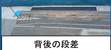
3号ふ頭護岸、ふ頭用地
