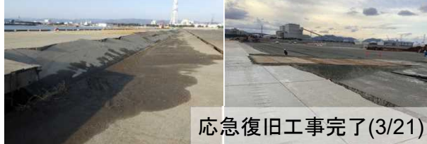
3号ふ頭岸壁 (-12m、耐震)
