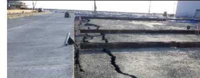
1号ふ頭6,7,8号岸壁
