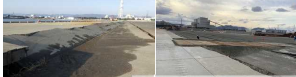
3号ふ頭岸壁 (-12m、耐震)
