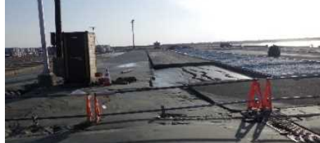
2号ふ頭2,3号岸壁
