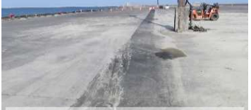
2号ふ頭4号岸壁
