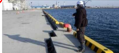
1号ふ頭1,2,3,4,5号岸壁
