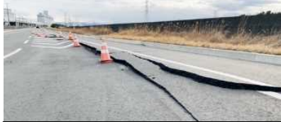
臨港道路5号ふ頭内線
