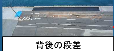
3号ふ頭護岸、ふ頭用地
