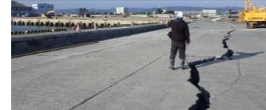
2号ふ頭1号岸壁
