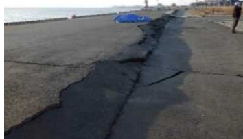
5号ふ頭4号岸壁
