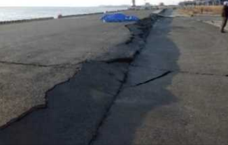
5号ふ頭4号岸壁
