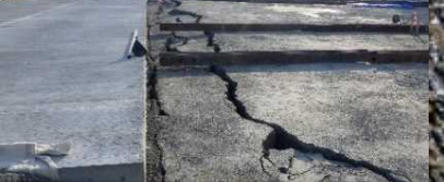
1号ふ頭6,7,8号岸壁
