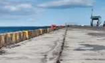
2号ふ頭4号岸壁
