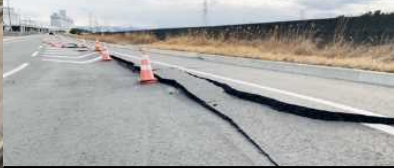
臨港道路5号ふ頭内線
