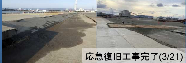
3号ふ頭岸壁(-12m、耐震)
