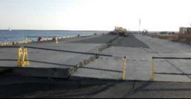
3号ふ頭4号岸壁
