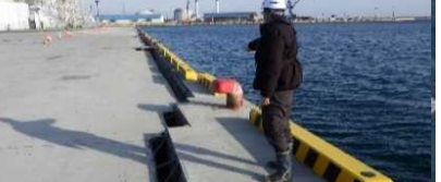
1号ふ頭1,2,3,4,5号岸壁
