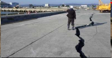
2号ふ頭1号岸壁
