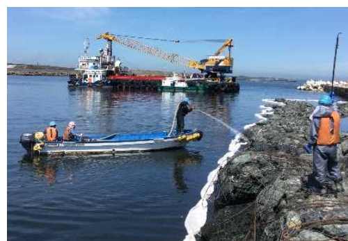
▲埋浚 護岸に付着した油の回収作業
