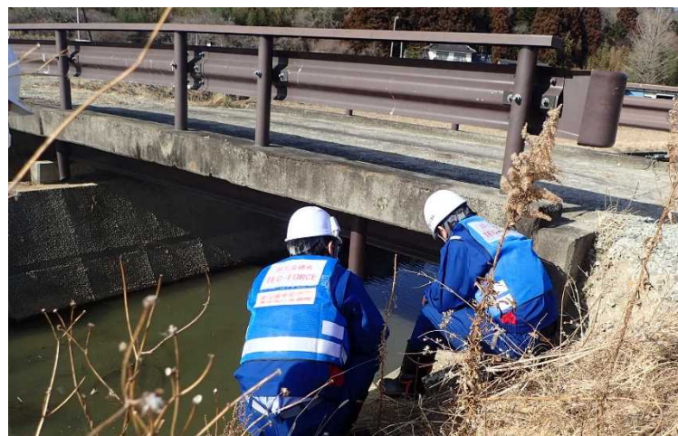
橋梁の被災状況調査状況
