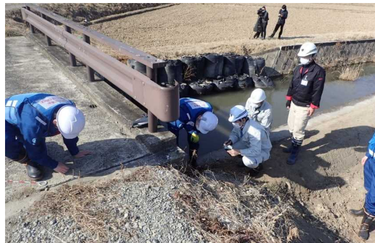
橋梁の被災状況調査状況
