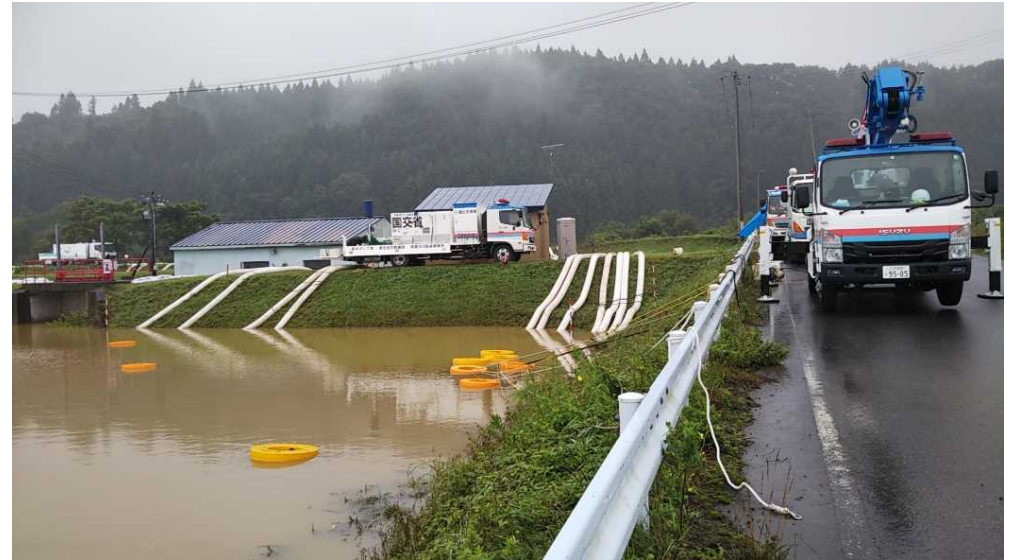
排水作業状況（青森県東北町）
