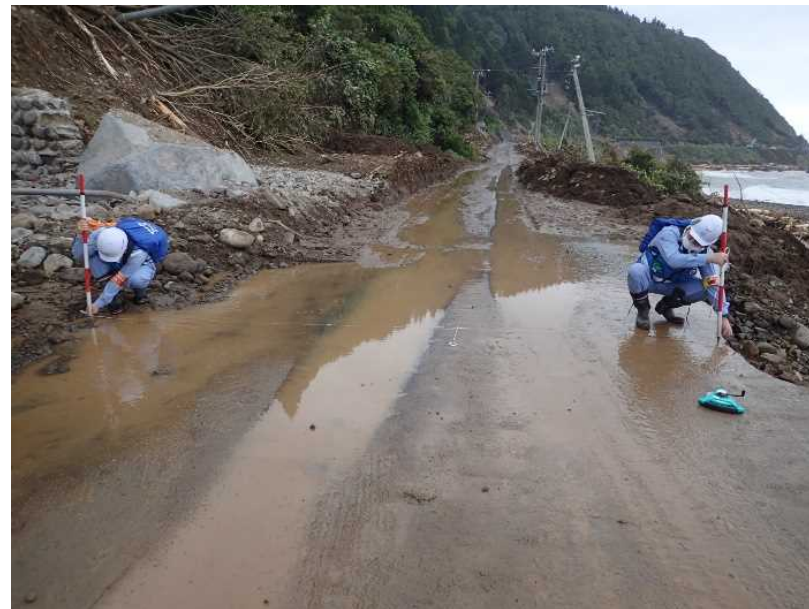
被災状況調査（青森県風間浦村）
