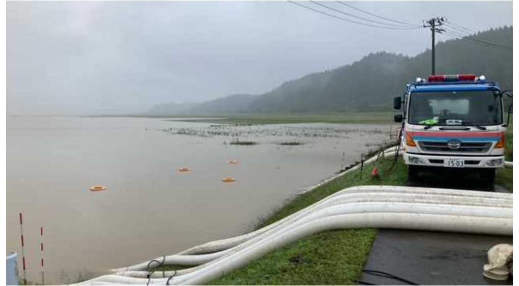
排水作業状況（青森県東北町）
