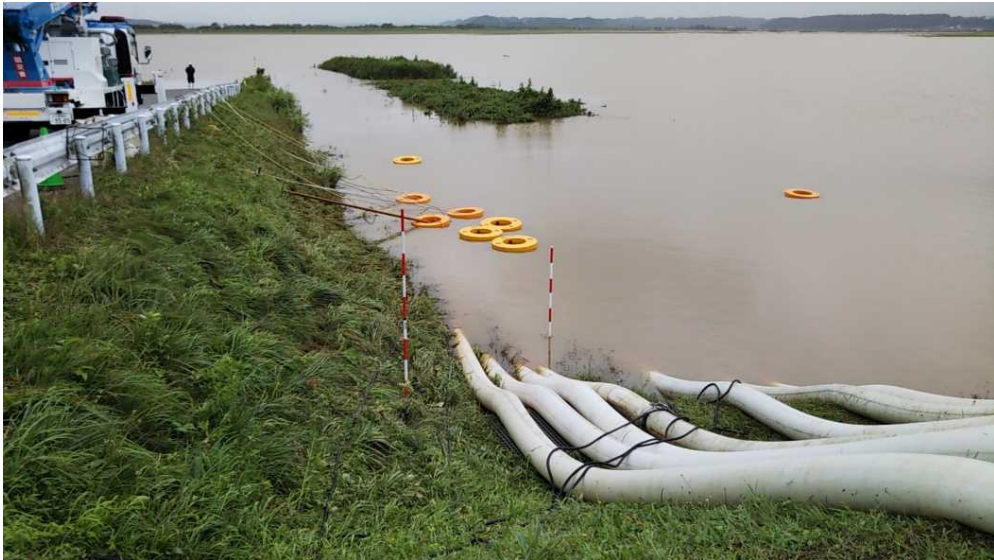
排水作業状況（青森県東北町）
