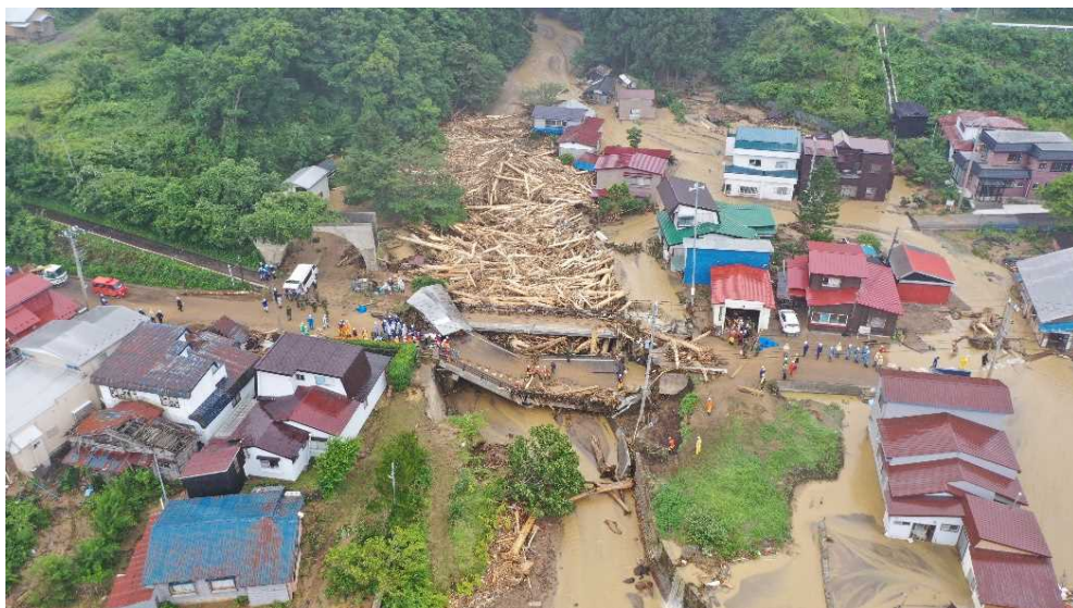
ドローンによる小赤川橋被災状況全景(青森県むつ市)
