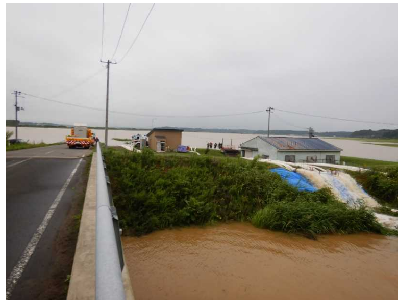
排水状況（青森県東北町）
