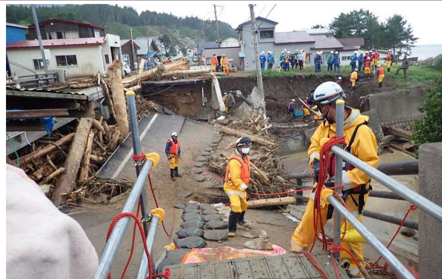
落橋した小赤川橋被災状況近景(青森県むつ市)
