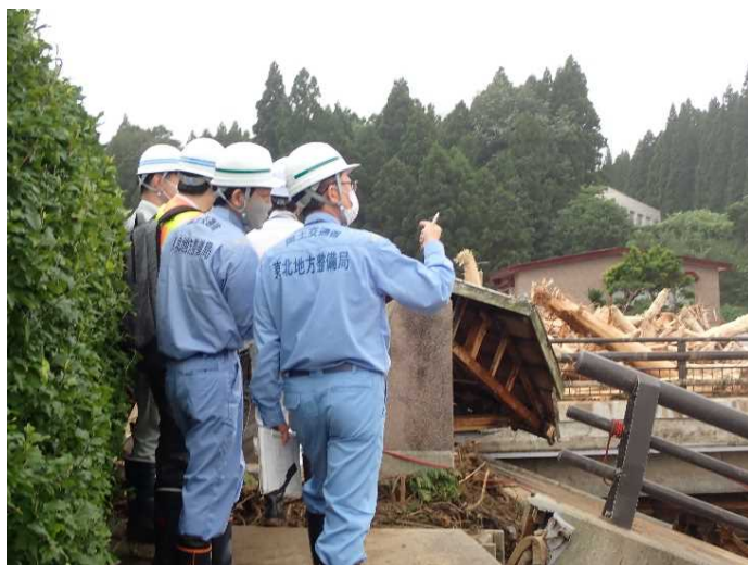
橋梁の被災調査状況
