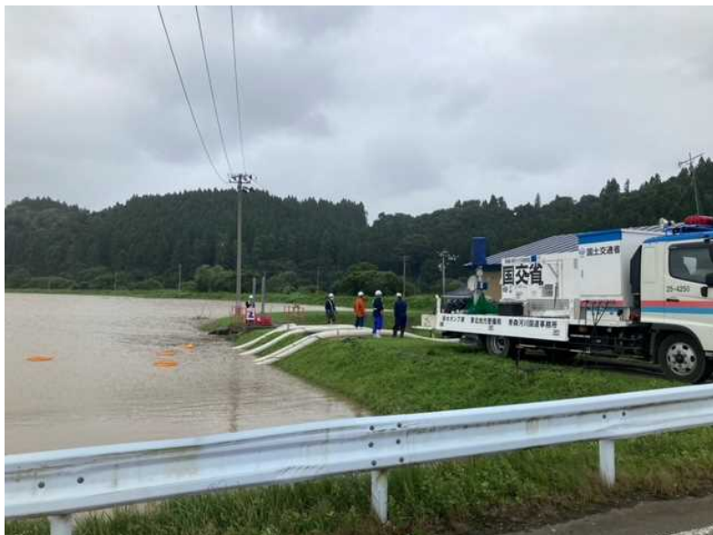
排水状況（青森県東北町）
