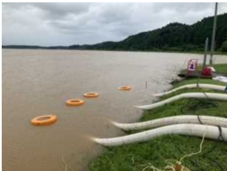
排水ポンプ設置状況（青森県東北町）
