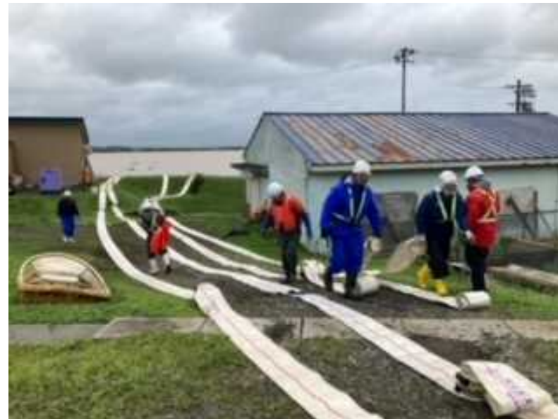
排水ポンプ設置状況（青森県東北町）
