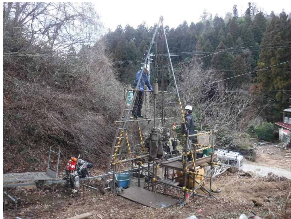
ボーリング実施状況
