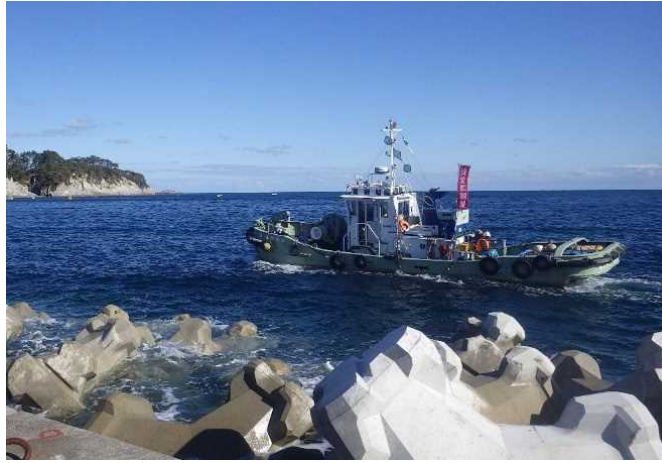
撮影年月日：R1.11.04 調査船による水中部の現地測量状況 (ナローマルチ)
