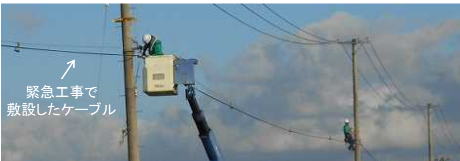
緊急復旧工事実施状況
