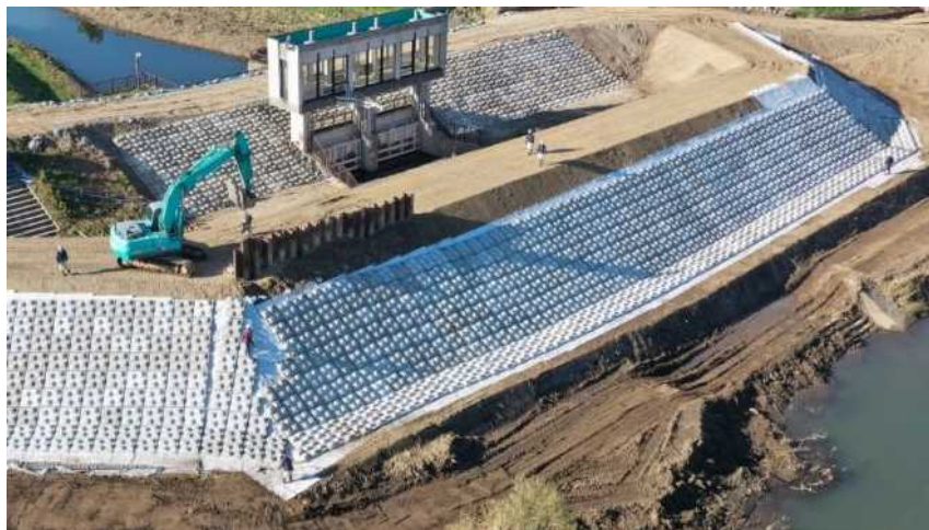
阿武隈川浜尾地区コンクリートブロック設置状況
