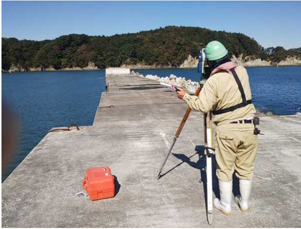
撮影年月日：R1.10.16 竜神崎地区防波堤水上部の現地確認状況
