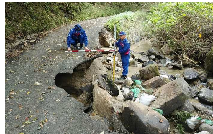
被災状況確認(道路)(宮城県丸森町大張)
