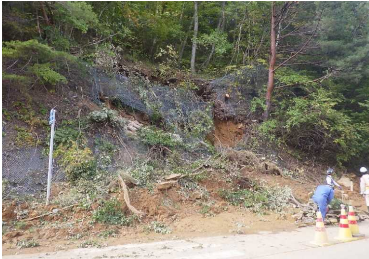
応急復旧状況(国道45号宮古市大字崎山地内)
