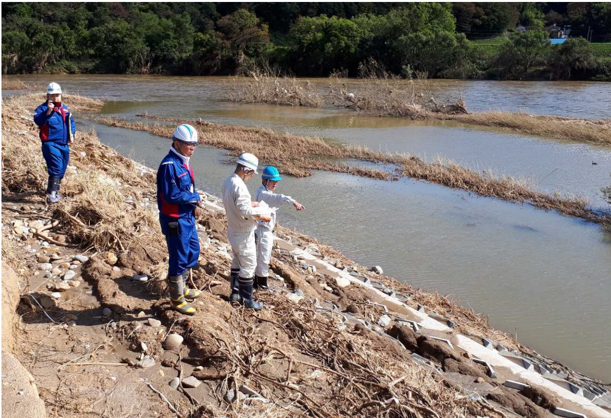
河川管理者と合同で河川護岸等の被害状況を調査(阿武隈川)
