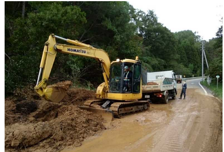
応急復旧状況(国道45号宮古市大字崎山地内)
