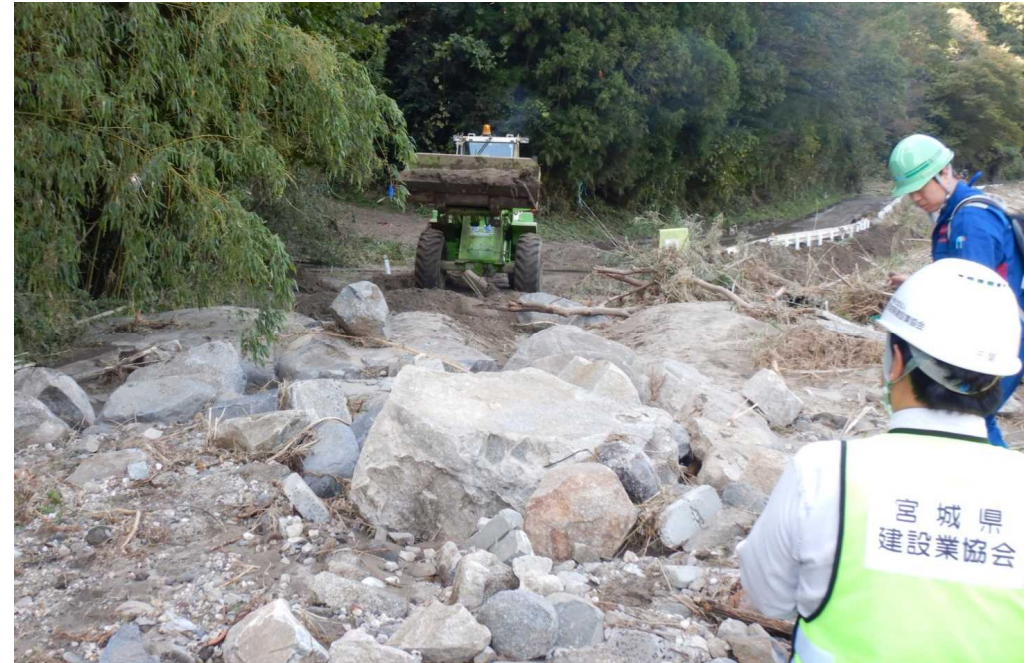
宮城県丸森町国道349号の道路啓開作業状況 (宮城県建設業協会)
