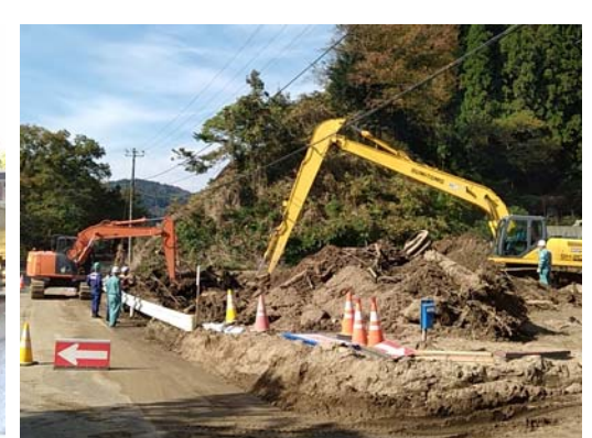
▲土砂撤去・整地作業状況
