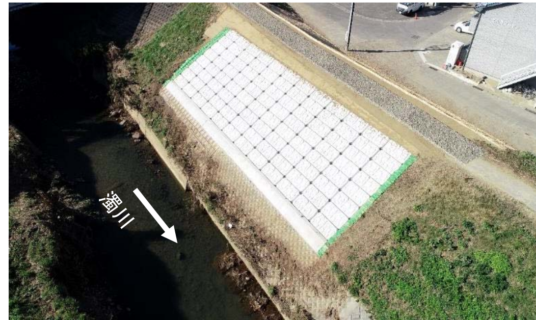
緊急復旧工事完了
