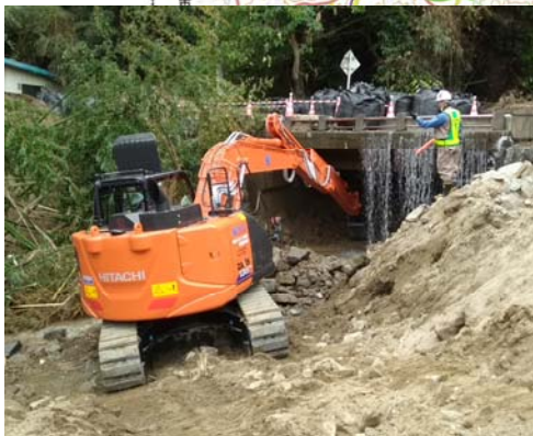
▲橋梁下閉塞土砂撤去作業状況
