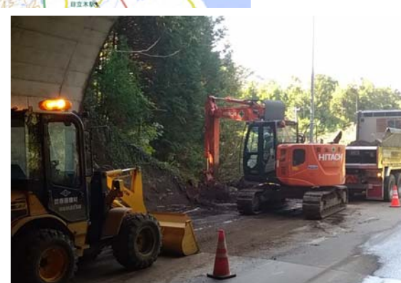
▲トンネル坑口土砂撤去・搬出作業状況
