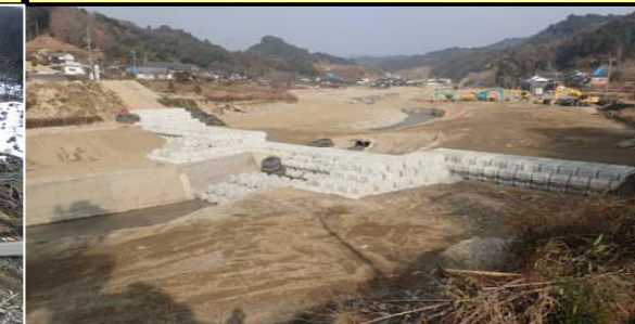
床固工 設置イメージ
