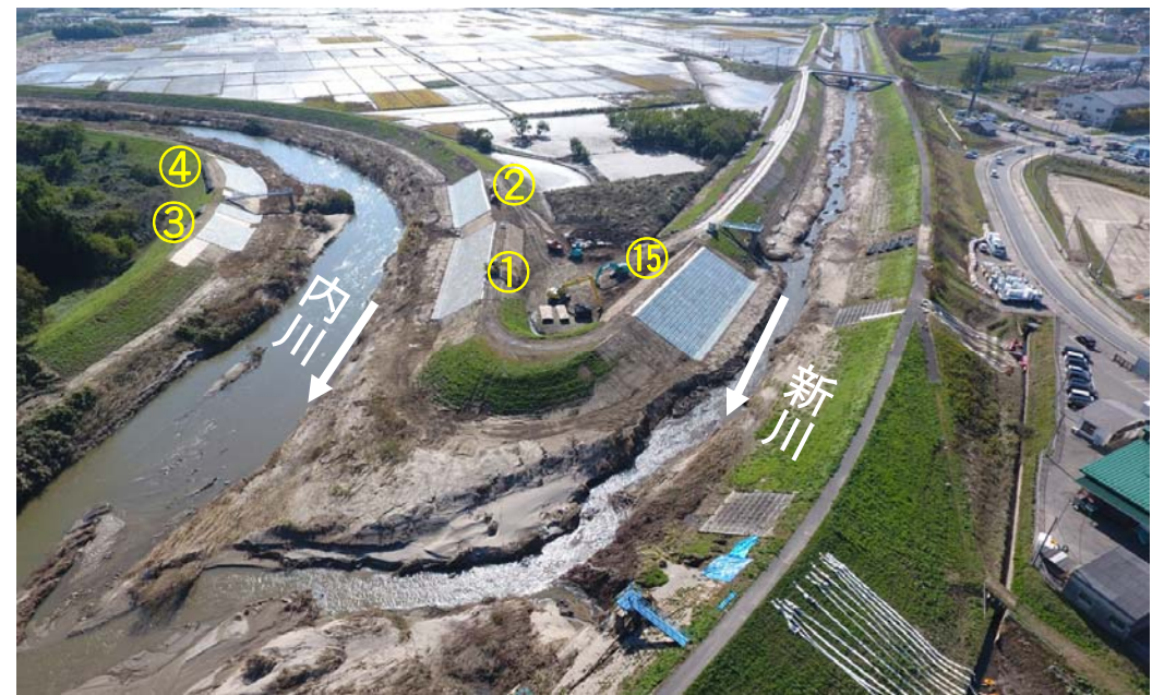
緊急復旧工事完了
