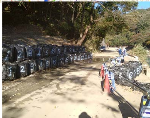
▲大型土のう製作・設置作業状況
