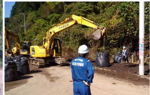
▲大型土のう設置
