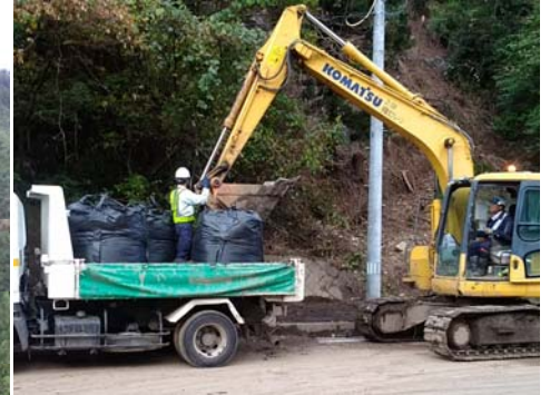
▲大型土のう製作
