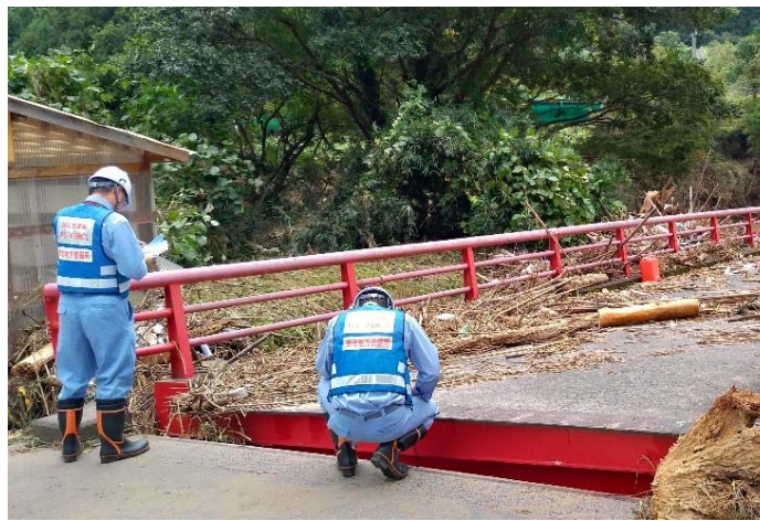
▲橋台の損傷状況調査
