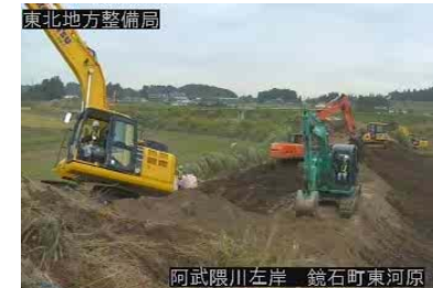
復旧工事状況
