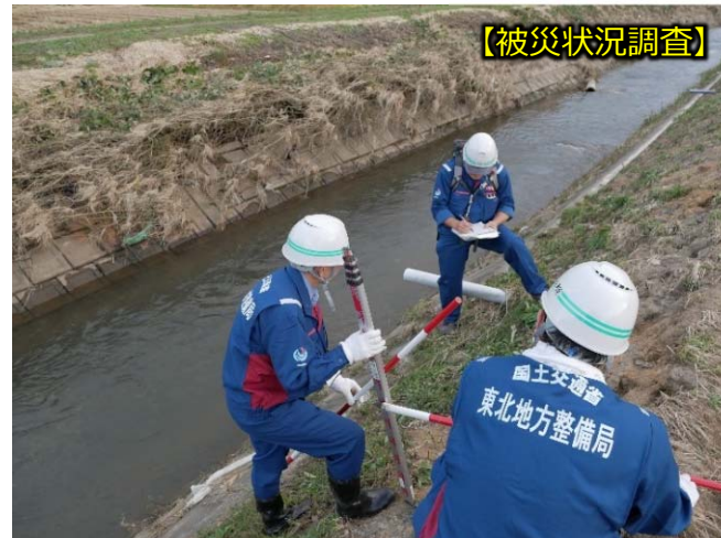
▲TEC-FORCEによる被災状況調査 (福島県矢吹町)
