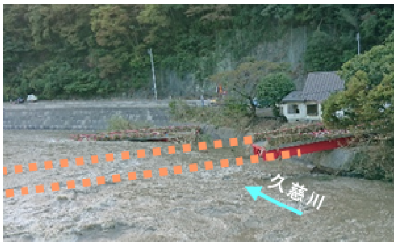
▲流失した たかちはら 高地原橋の被害状況
