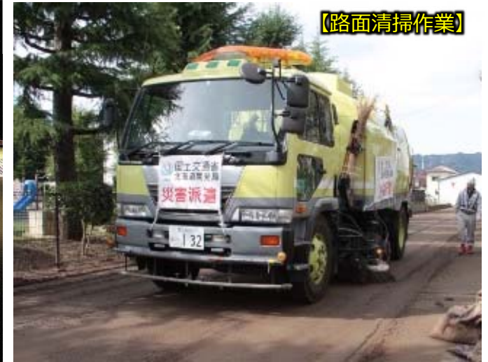
▲路面清掃車による路面清掃作業(福島県相馬市)
