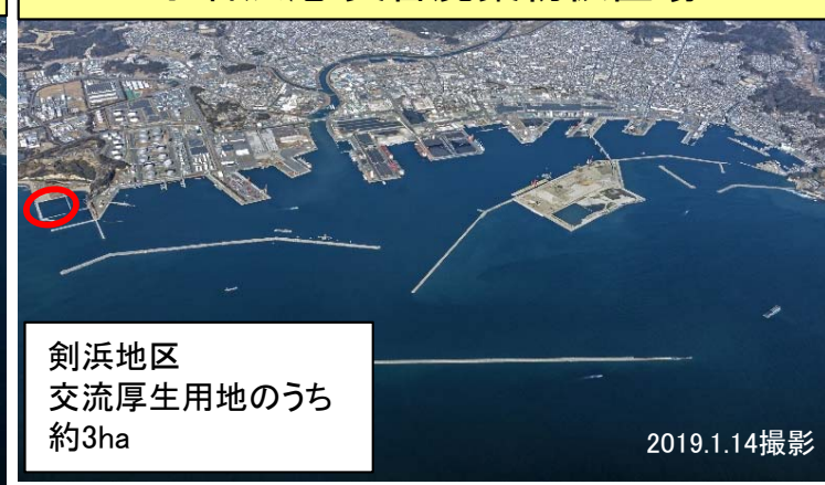
小名浜港 災害廃棄物仮置場
