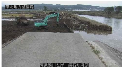
復旧工事状況
