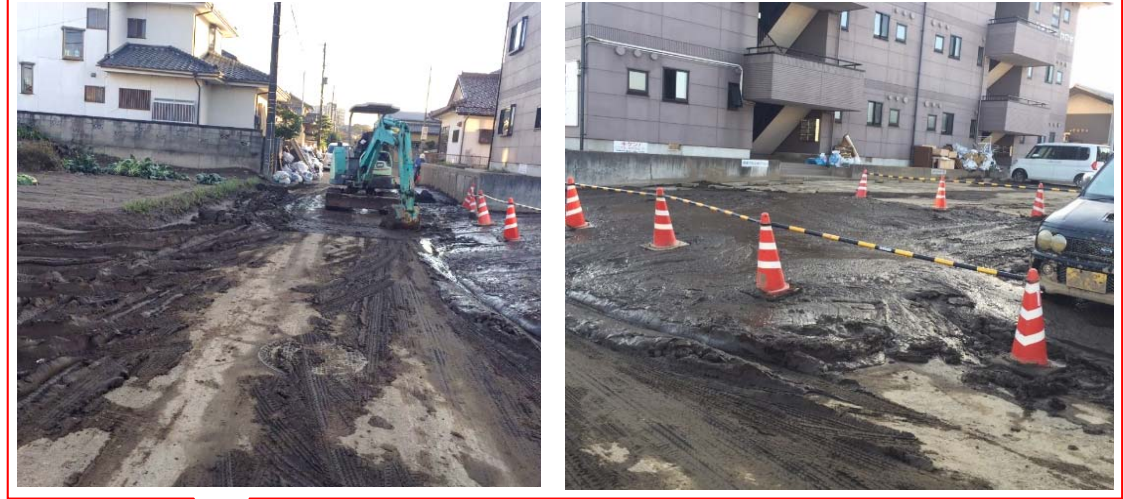
宅地等への土砂堆積状況(須賀川市中宿地内)
