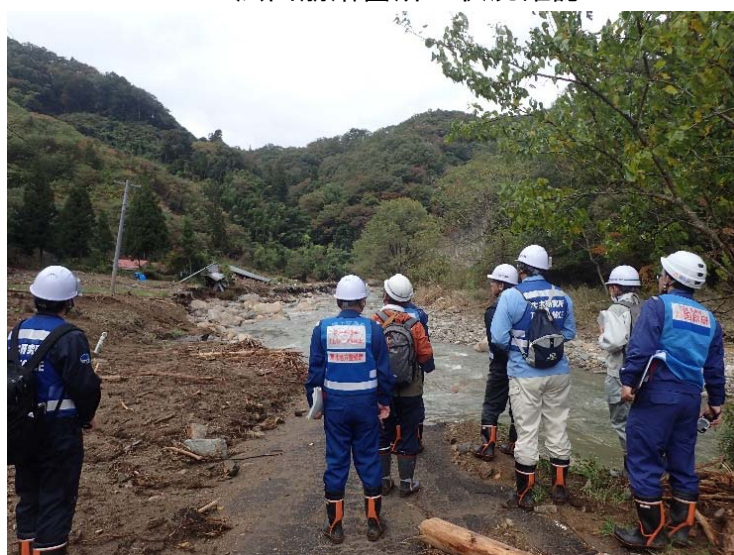
道路流失箇所の状況確認
