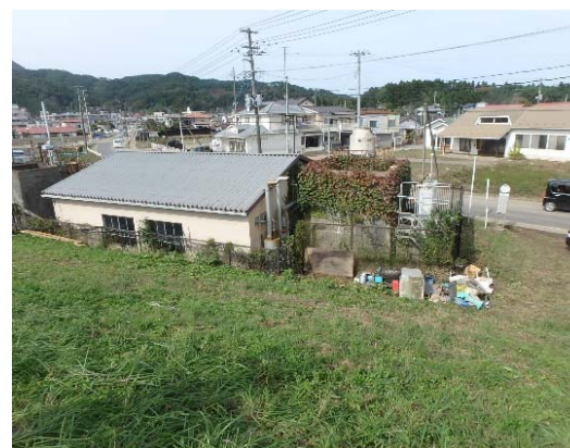
丸森雨水ポンプ場の浸水状況
