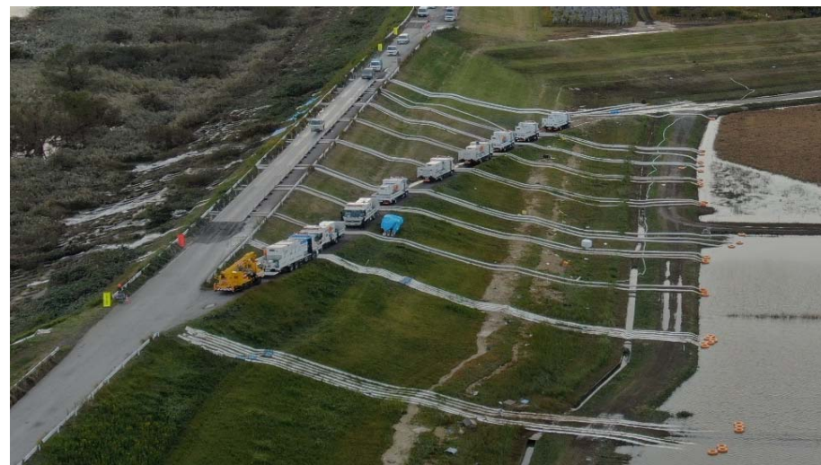
吉田川における排水作業状況
