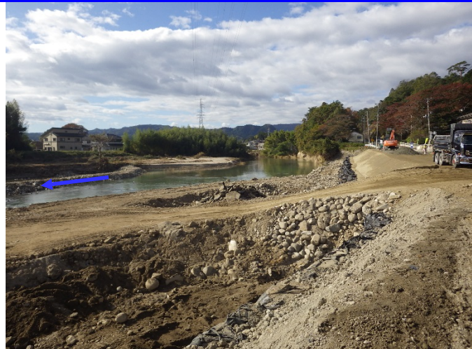
現地状況調査 宇多川(県区間) (福島県相馬市 宇多川)
