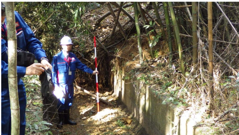
南相馬市原町区北新田東畑地内 河道閉塞状況
