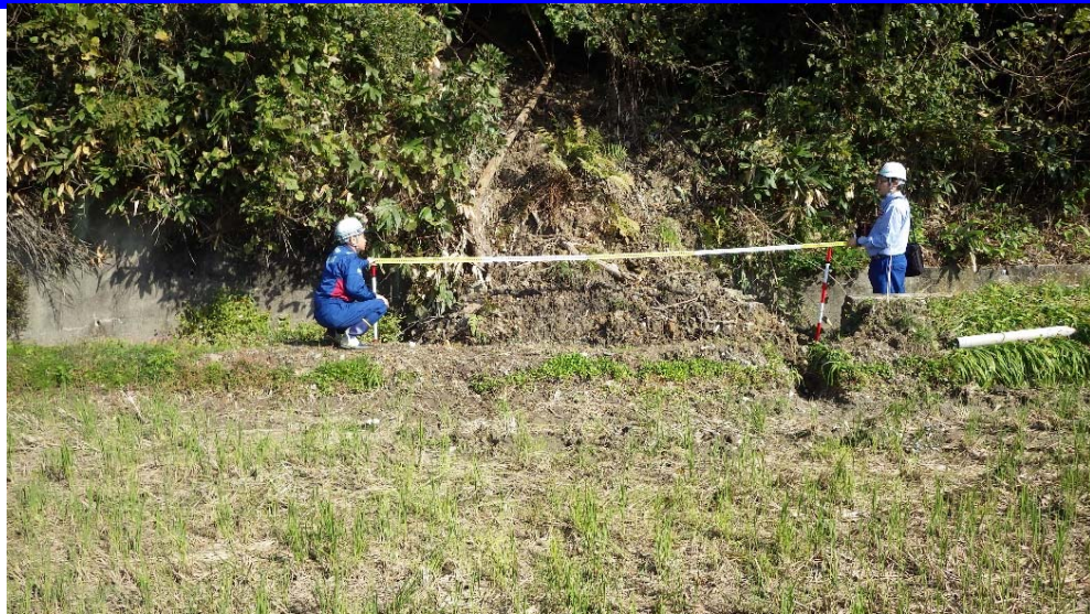
南相馬市原町区上北高平高松地内 河道閉塞状況
