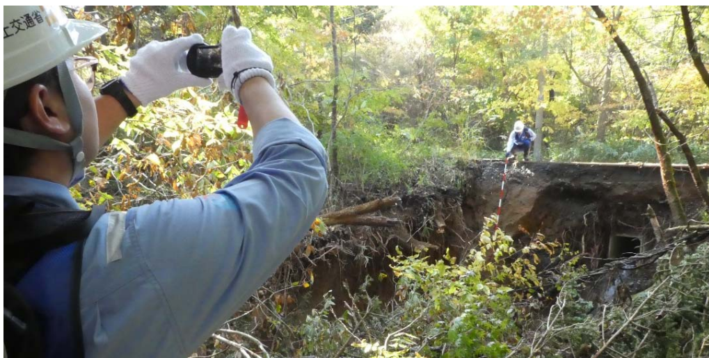
被災状況調査を実施 (福島県相馬市 市道2354号線)
