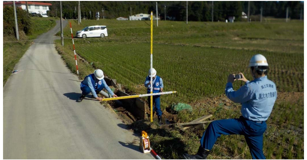
被災状況調査を実施 (福島県相馬市 市道1539線)
