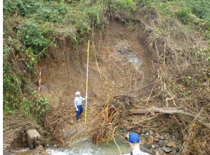
被災状況調査状況(調査①) 宮城県角田市 桜井川 被災状況(法面崩落)
