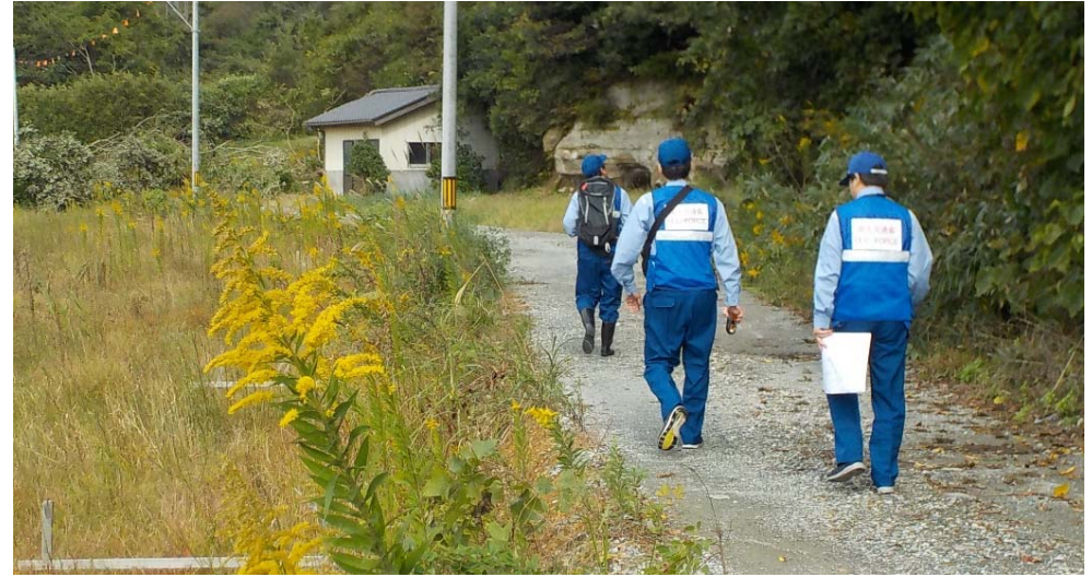
被災状況調査を実施 (福島県相馬市 市道1571線 )
