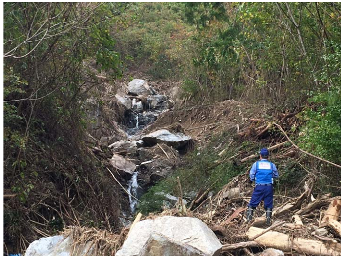
復旧対策に向けた調査状況 (宮城県丸森町 内川)
