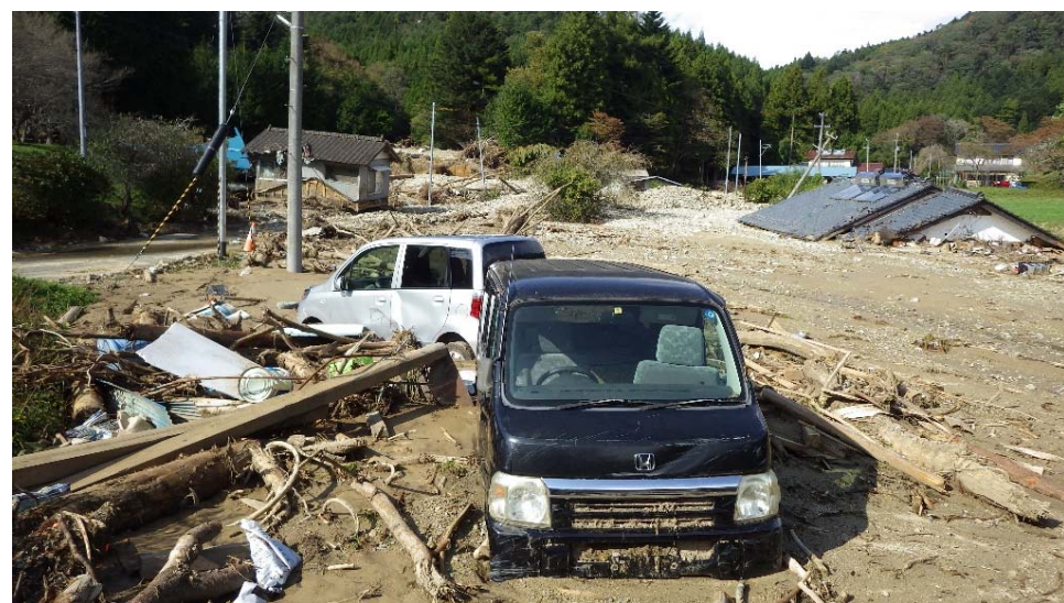
南相馬市原町区大原地内 土石流による被害状況
