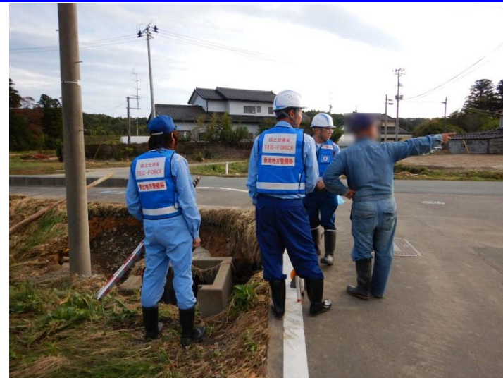
被災状況聞き取り (福島県相馬市 市道1470)
