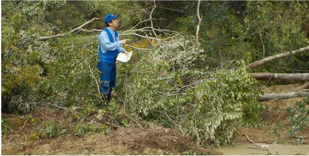
被災状況調査を実施 (福島県相馬市 市道1577線)
