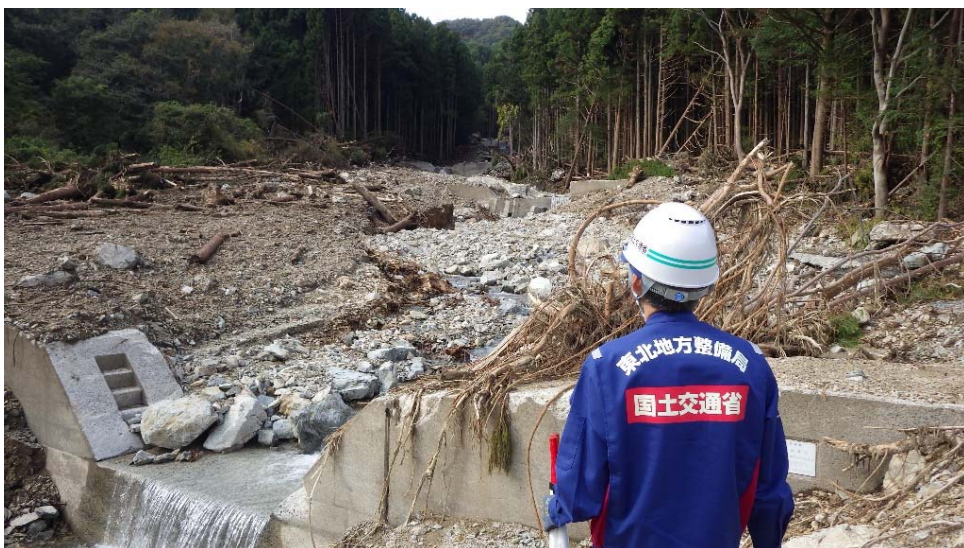
南相馬市原町区大原地内 土石流の発生状況
