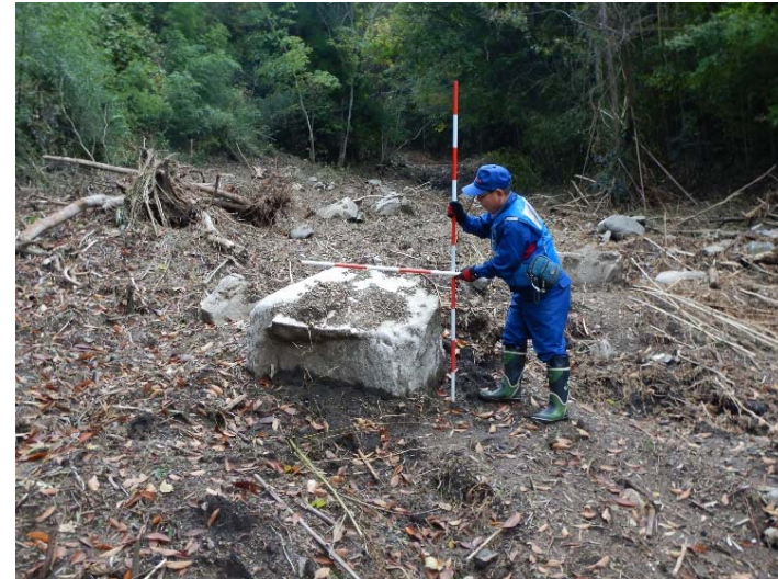
被災状況調査状況 (宮城県丸森町 五福谷川)
