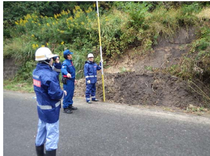
被災状況調査状況(調査①) 宮城県角田市 市道205号 被災状況(レーザー計測)
