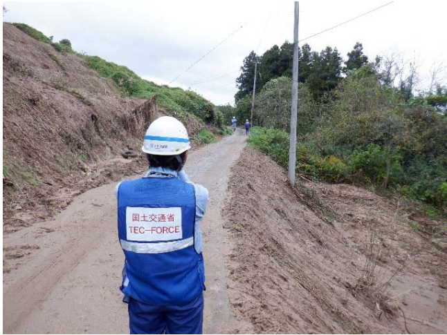
現地確認状況 福島県伊達市梁川町五十沢 地内
