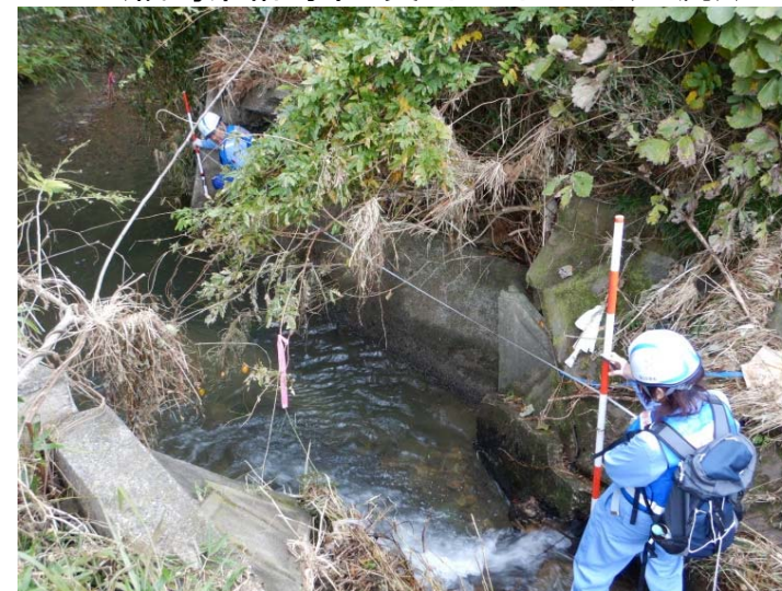
被災状況調査状況(巻き尺による計測) (福島県相馬市 支川日下石川(上流))
