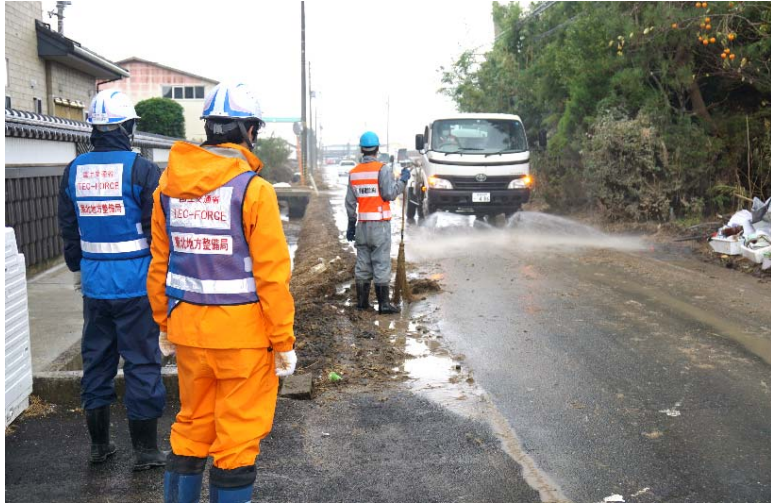
道路啓開作業の現場監督 (大崎市鹿島台大迫下志田地区)
