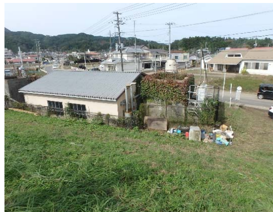
丸森雨水ポンプ場の浸水状況
