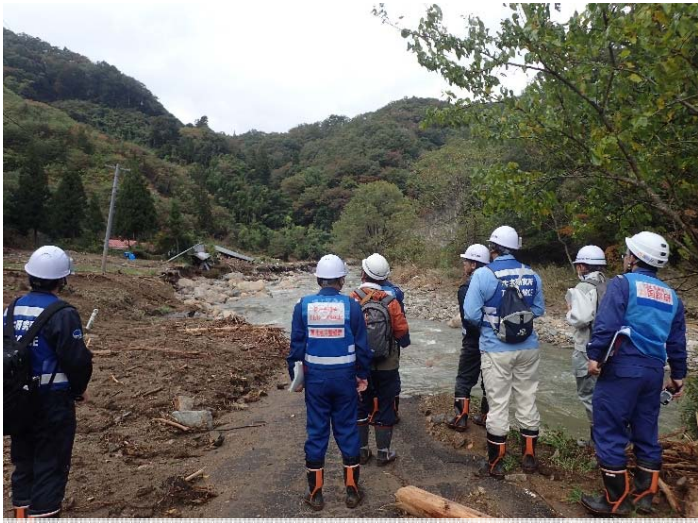
道路流失箇所 の状況確認
