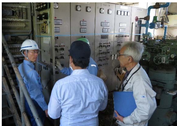
現地調査状況 下水道専門家による被害状況の確認
