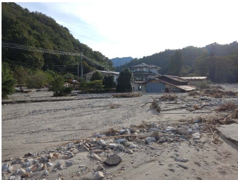
土砂洪水氾濫による家屋の埋没状況(五福谷川)
