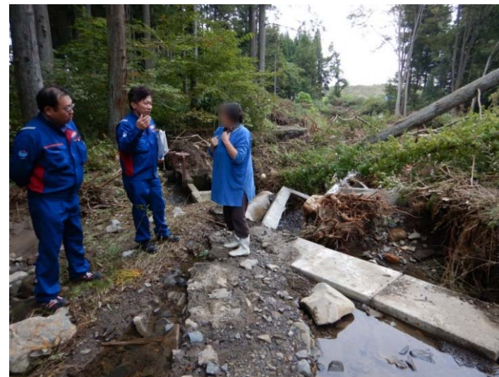
現地住民からの聞き込み (福島県白河市 坂下川)
