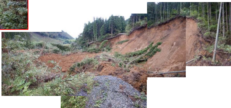
被災状況調査状況 (福島県白河市 坂下川)
