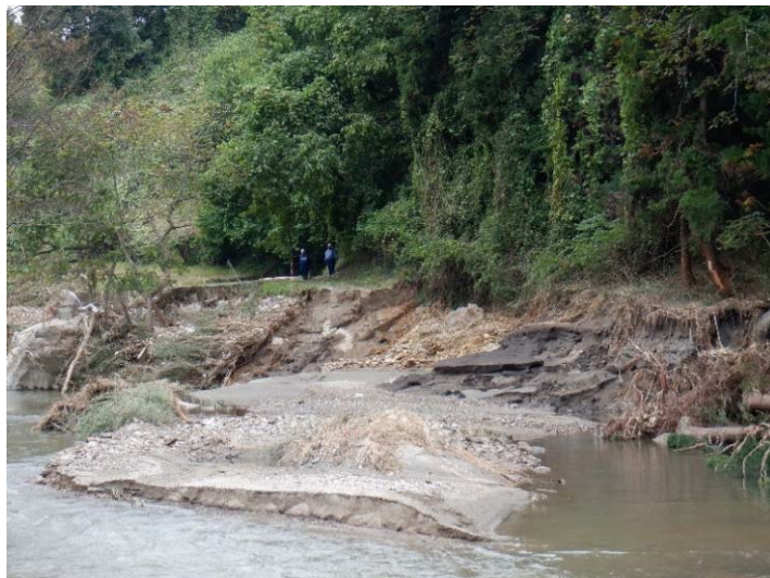
被災状況調査状況
