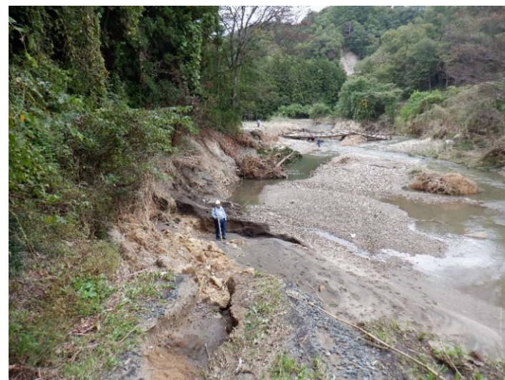
被災状況調査状況(調査⑨)
