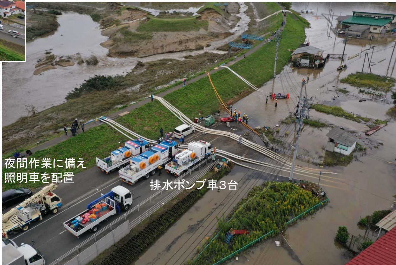
排水ポンプ車3台による排水作業
