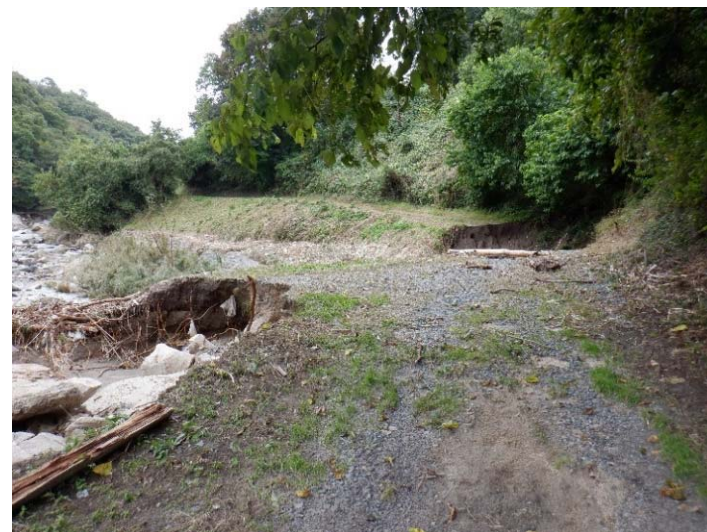
被災状況調査状況
