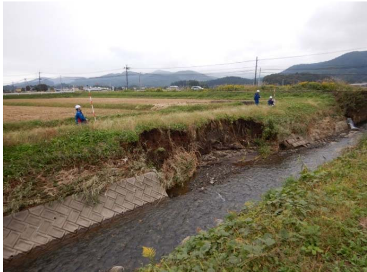
被災状況調査状況 (福島県白河市 坂下川)
