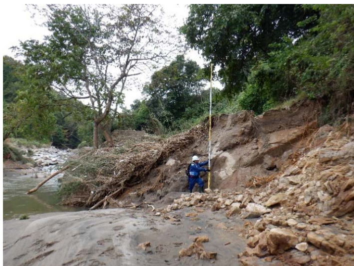
被災状況調査状況
