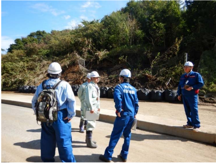
被災調査状況 (福島県白河 白河中央スマートICアクセス道路(市道))
