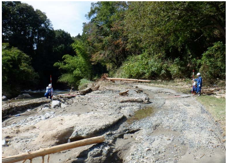
被災状況調査状況(調査⑥)
