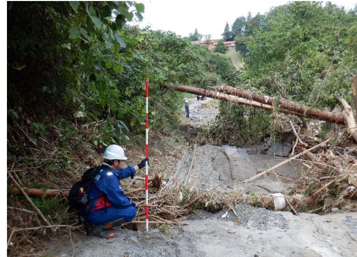
被災状況調査状況(調査⑦)
