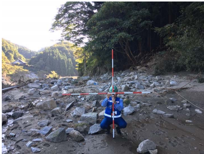
被災状況調査状況 (宮城県丸森町 R349)
