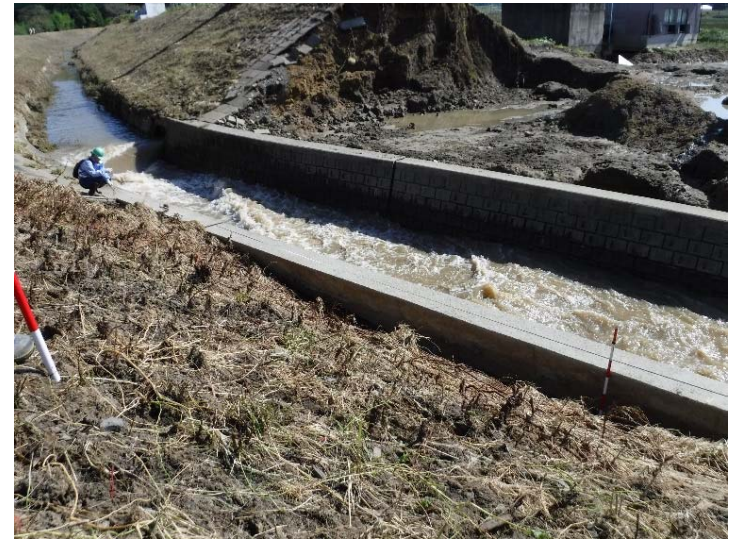
被災状況調査状況 (宮城県角田市 庄司堀)
