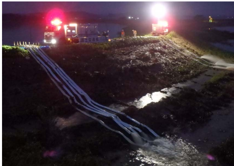
応急対策班 鳴瀬川水系吉田川 排水ポンプ車による排水作業を実施
