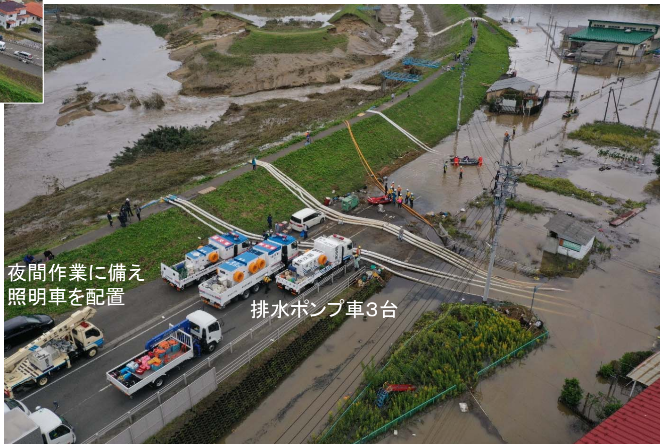
排水ポンプ車3台による排水作業
