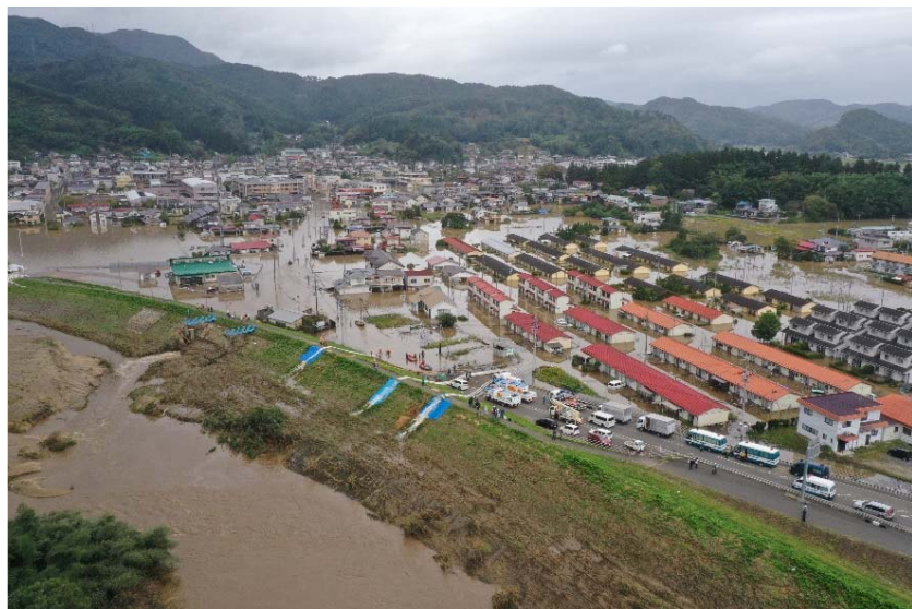
丸森町中心部の浸水状況
