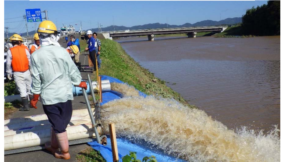
排水活動状況② (宮城県丸森町)
