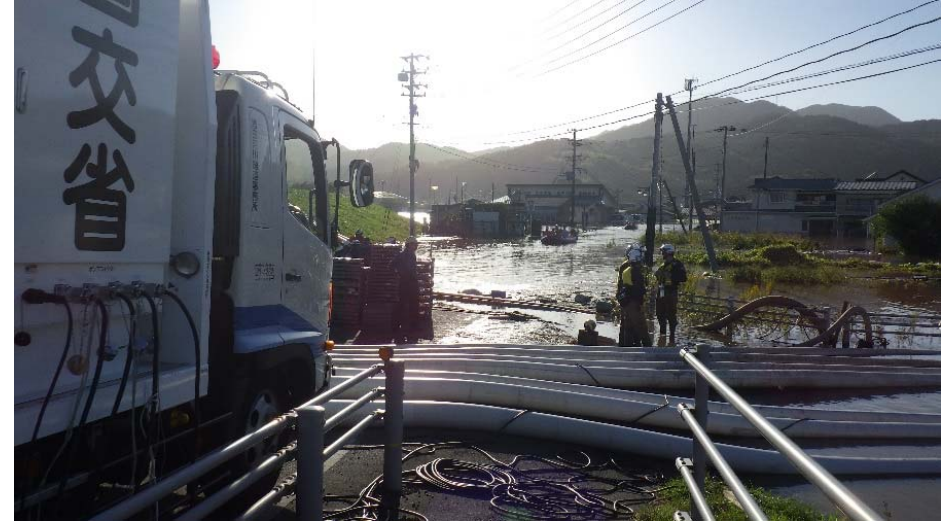
△排水ポンプ車の配備状況② (宮城県丸森町)
