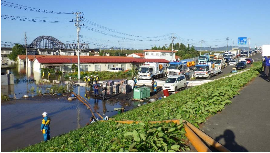
△排水ポンプ車の配備状況① (宮城県丸森町)
