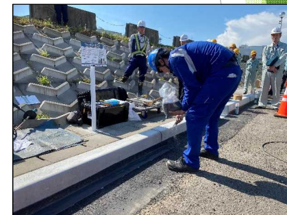
○防草技術の施工の様子
