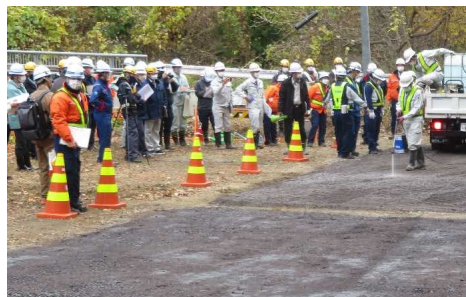
○④施工中の現場状況
