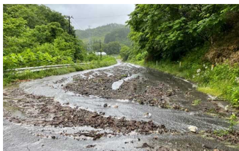
○大雨による市道への碎石流出状況
