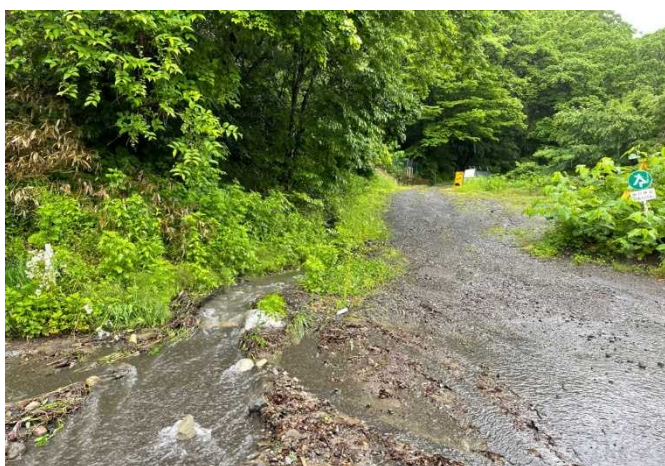
・砂利道からの碎石流出の状況
