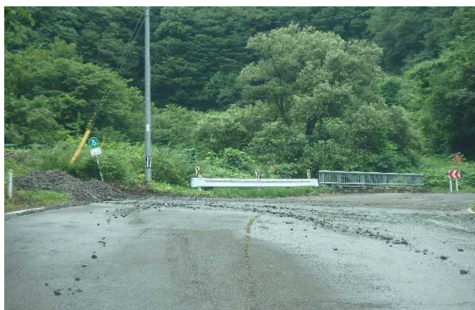
・碎石清掃後の状況
