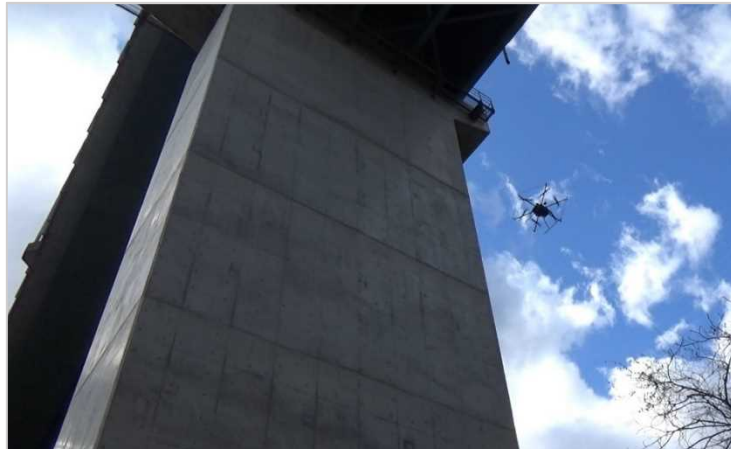
ドローンによるインフラ構造物点検
