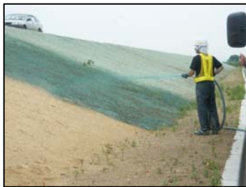
写真-1 種子吹き付けの施工状況
