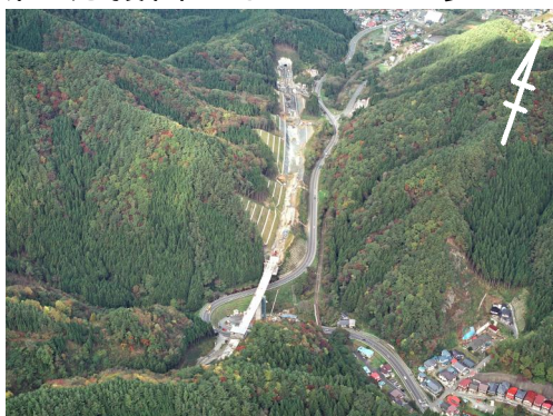
事業中の釜石山田道路
