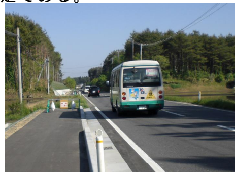
現時点での歩道整備状況
