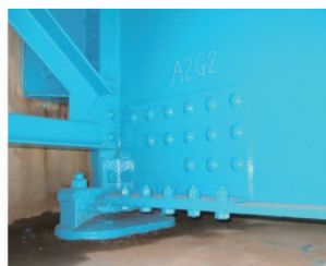
対策後(当て板補強・塗装)
