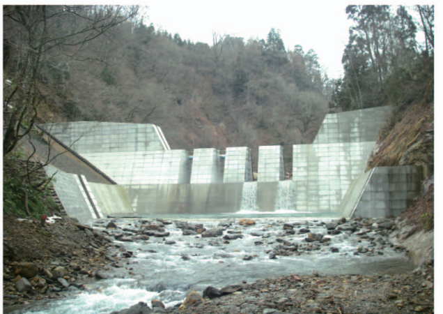
万助川砂防えん堤(山形県最上郡真室川町)
