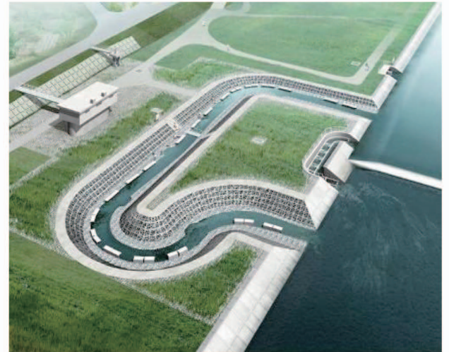
多様な魚類が遡上できる「緩勾配式魚道」 (岩木川水系/青森県中泊町)
