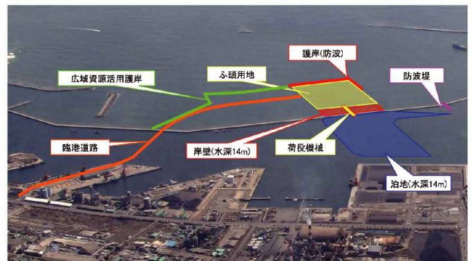
小名浜港 多目的国際ターミナル・広域資源活用護岸
