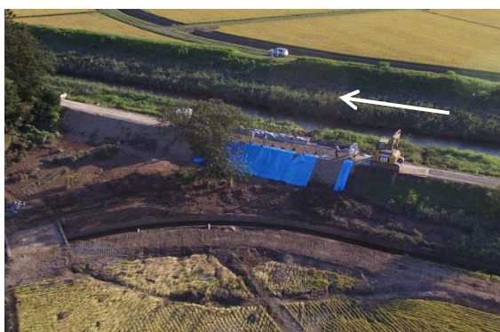
上流地区復旧状況(15日16:20)
