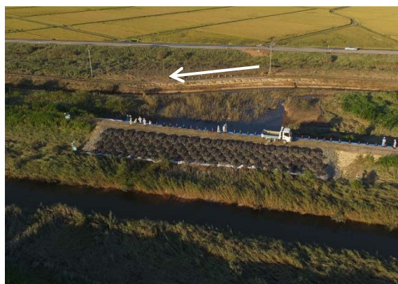
下流地区復旧状況(15日16:40)
