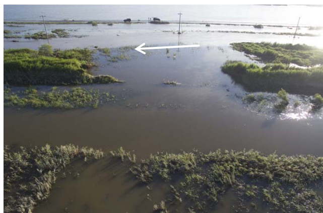
下流地区破堤箇所(12日6:00)
