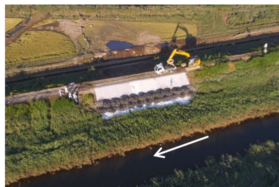
中流地区復旧状況(15日16:45)
