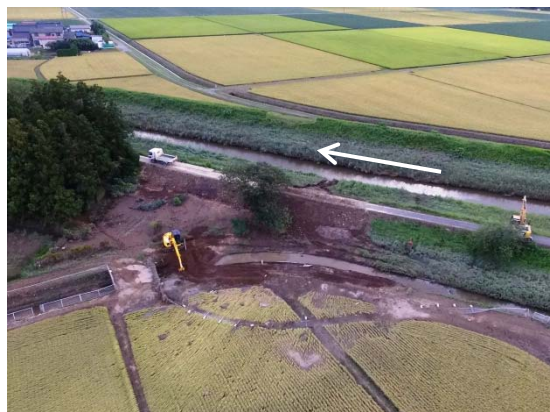
上流工区復旧状況(14日16:30)
