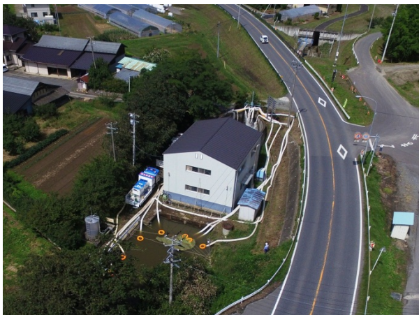
涌谷町での排水作業(14日11:00)
