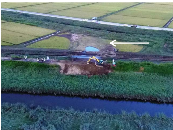
中流工区復旧状況(14日17:00)
