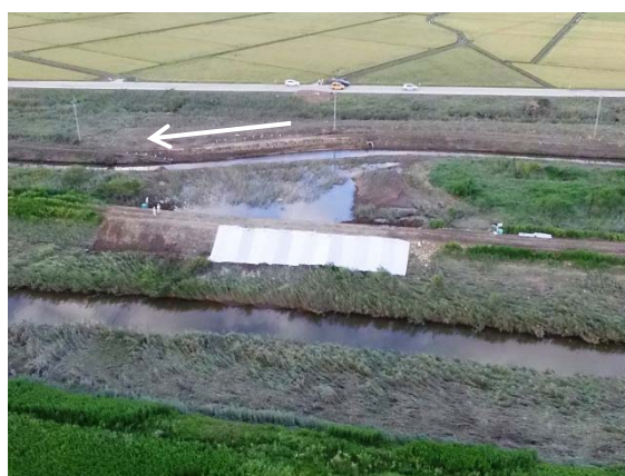
下流工区復旧状況(14日16:30)
