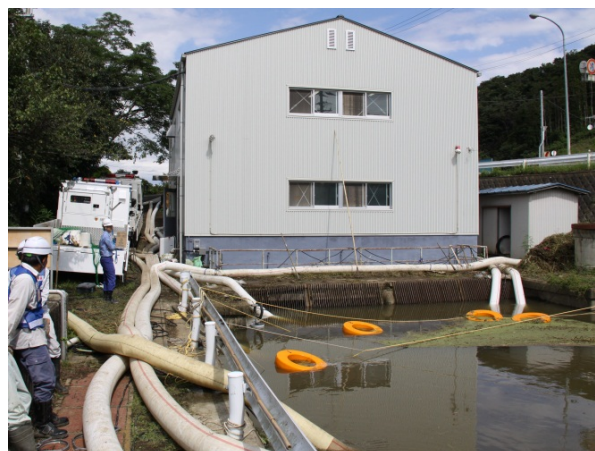
涌谷町での排水作業(14日11:00)
