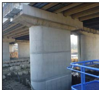
【橋脚の巻き立て補強】
