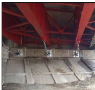
【落橋防止チェーン設置】
