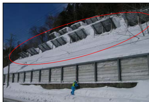
【雪崩防止柵を整備】
