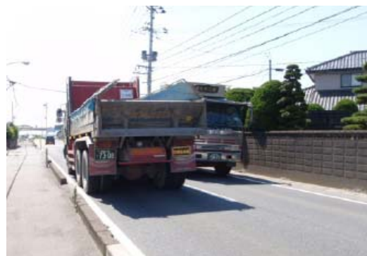
▲ 現道の大型車すれ違いが困難な状況
