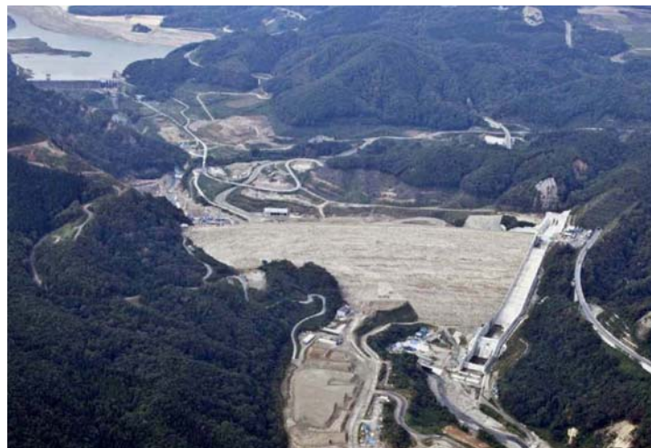
平成24年12月から試験湛水を行う予定の 胆沢ダム
