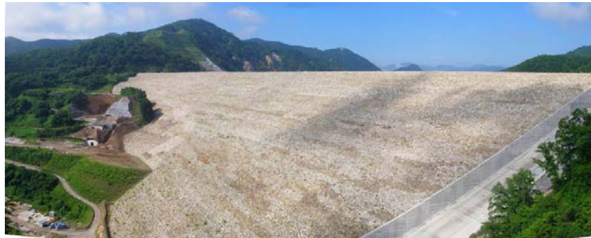
ダム堤体状況(平成24年8月)
