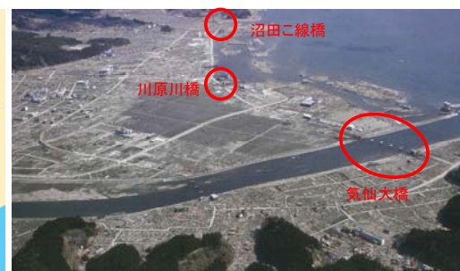
▲陸前高田市内の被災状況
