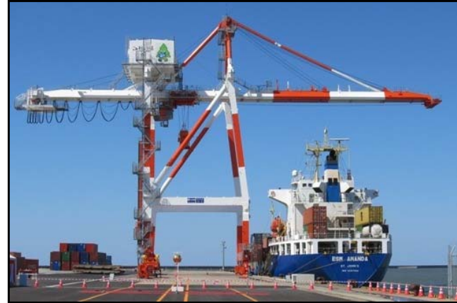
▲ 荷役作業の効率性向上 (外港2号岸壁)
