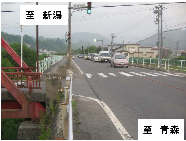
▲右折車線がない当該交差点の現況
