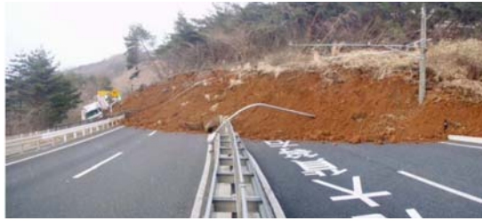
▲国道4号伏拝地区の土砂崩落状況(H23.3.11)
