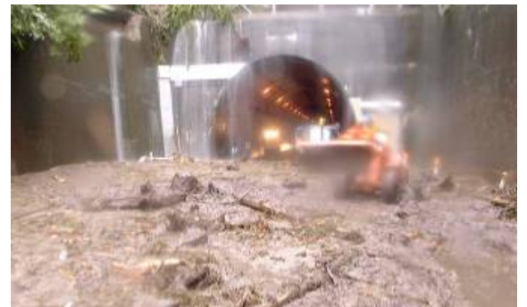
▲羅生トンネル北口における切土法面崩落(H14.7.11)
