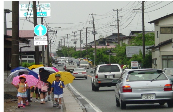
▲現道区間の歩道幅員狭小区間
