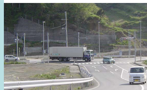
陸前高田市高田地区 国道45号の直角曲がり箇所
