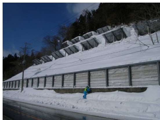
雪崩防止柵設置
