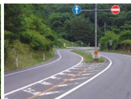
▲現道状況(国道283号)
