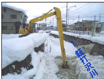
▲閉塞した鉦打沢川の復旧状況
