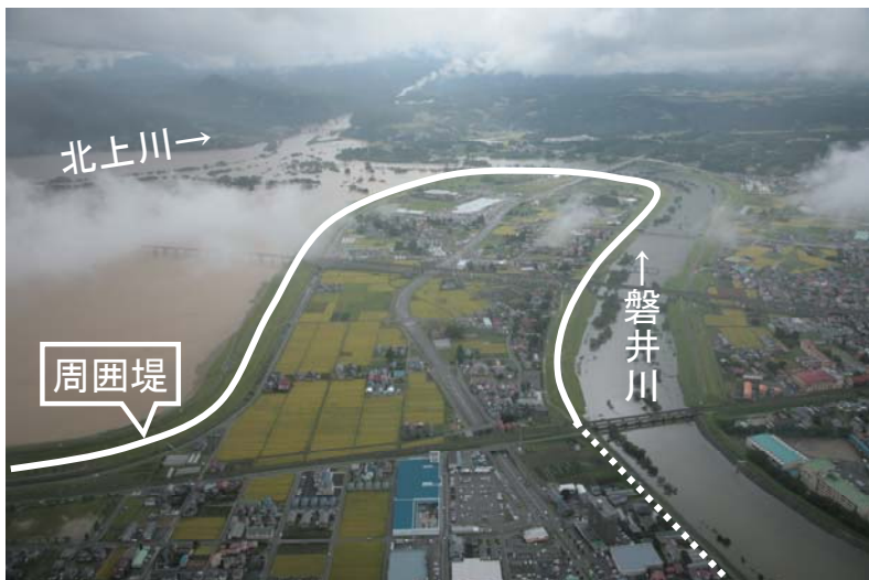
▲H19.9出水状況
