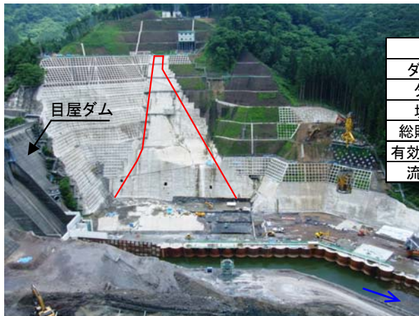
平成22年5月から堤体打設を開始した津軽ダム
