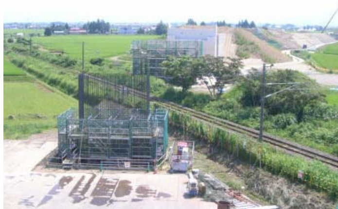
▲施工状況(姥堂橋)
