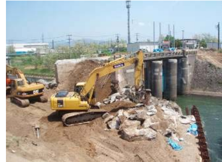
▲新屋水門工事の残土を盛土に流用しコスト縮減
