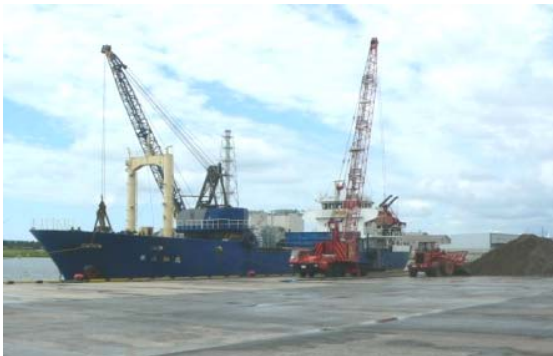
▲廃土砂の運搬状況
