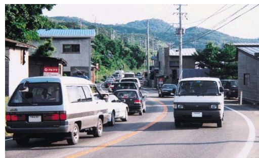
▲線形隘路区間の状況
