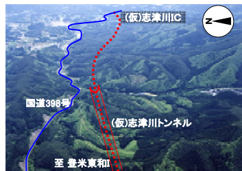
▲(仮)志津川トンネル付近
