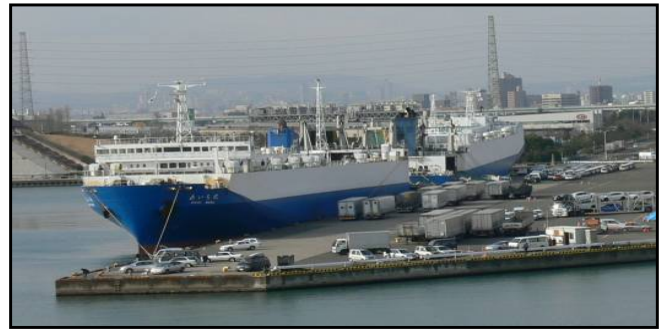
▲中野地区の利用状況 (大型自動車運搬船接岸状況)
