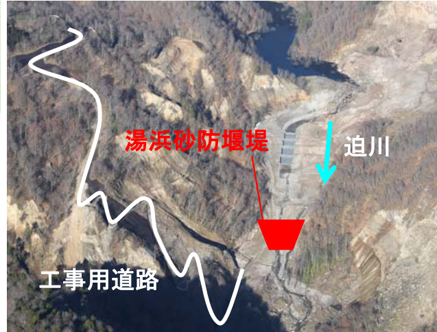
湯浜砂防堰堤
