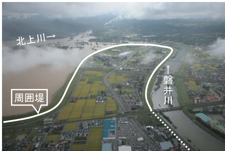
▲H19.9出水状況
