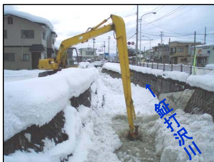
▲閉塞した鉦打沢川の復旧状況
