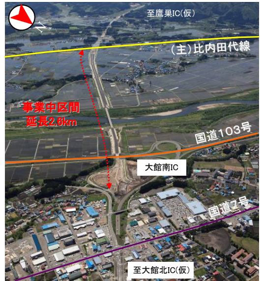
▲大館南ICから起点側を望む
