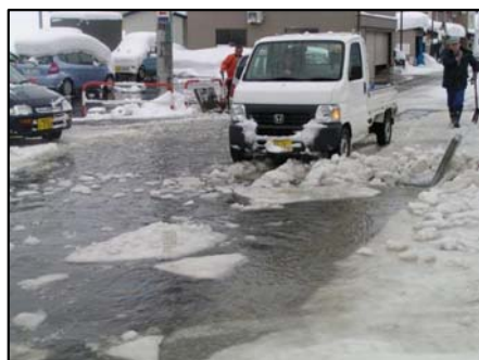
▲流雪溝の閉塞により道路が冠水している状況
