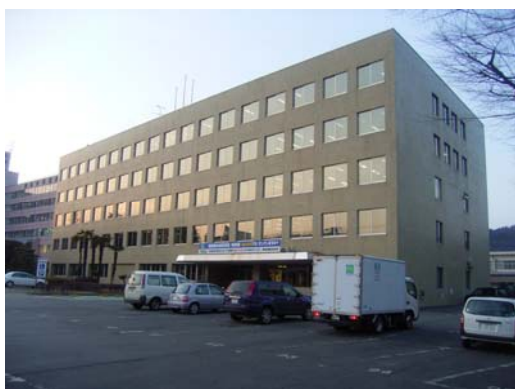
▲ 福島地方合同庁舎
