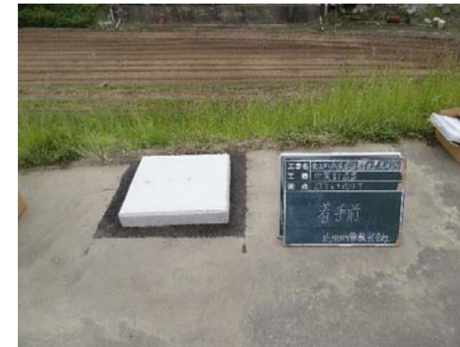
1) コンクリートベース設置
