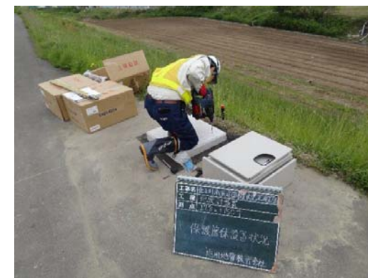
3) アンカー用穴 削孔
