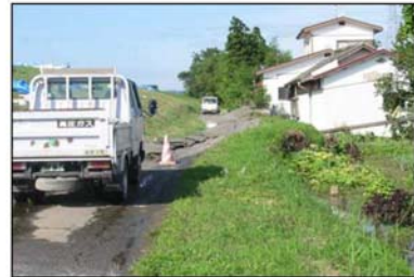
H15地震後の被災状況(民家の傾斜)
