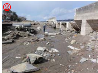
図一 20 津波による堤防被災状況(鳴瀬川)
