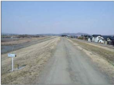
今回の地震後の状況(対策工部に変状なし)
