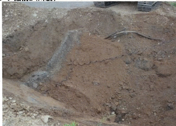
川裏部 掘削状況
