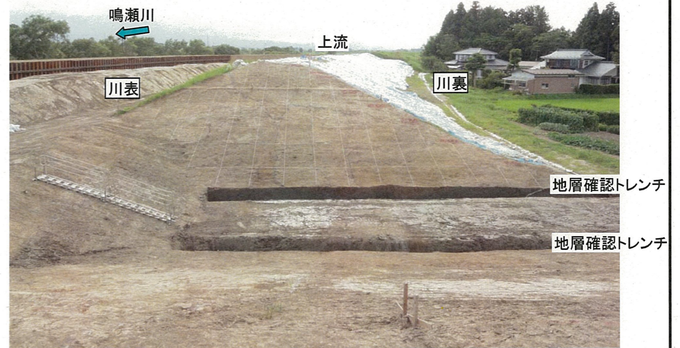
上流側法面(下流側天端から撮影)
