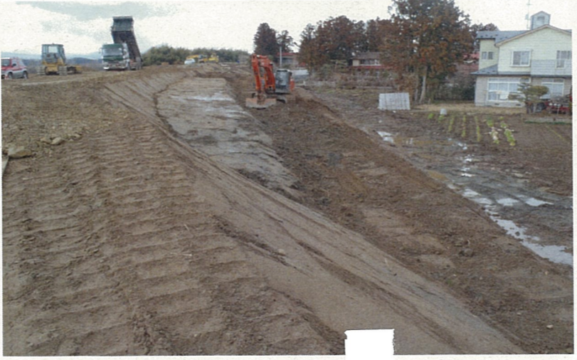
④仮復旧工事 3/26撮影
