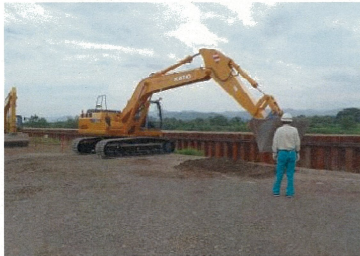
川表部 掘削状況
