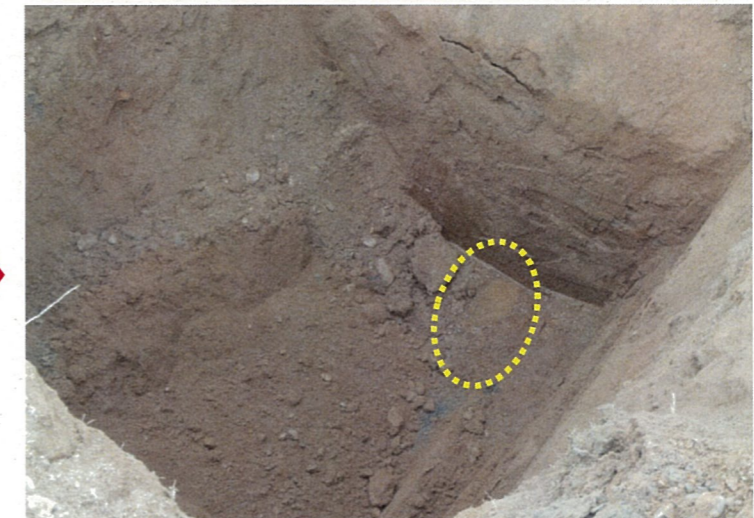
掘削状況：掘削底面部にて水位確認
