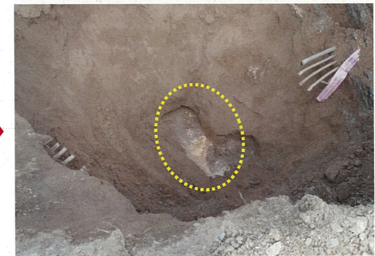
掘削状況：掘削底面部にて水位確認
