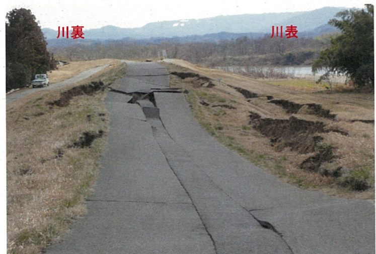
①右岸30.8k付近: 縦断クラック発生 深さは1.00m程度。
