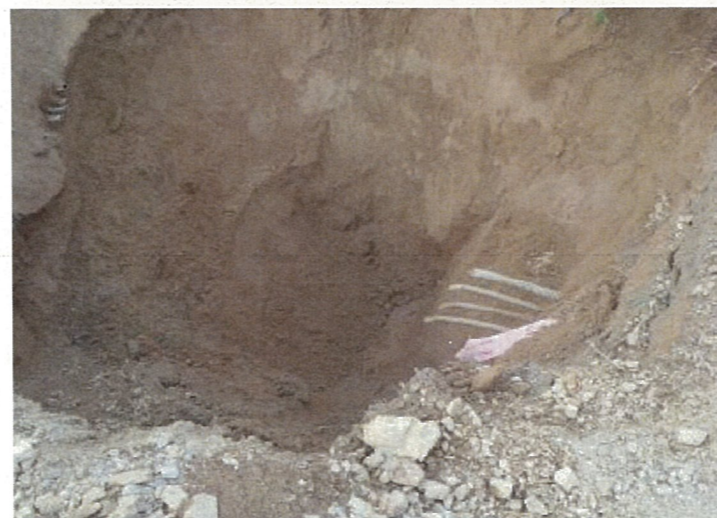
掘削状況：掘削底面部暗灰色の砂層確認
