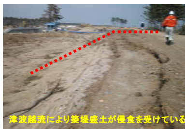
左岸・藤塚堤防(川裏)
