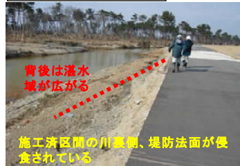
左岸・藤塚堤防(川裏)
