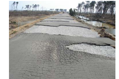
左岸・藤塚堤防(川裏)
