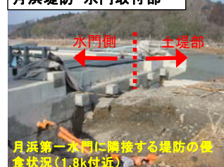
月浜堤防・水門取付部
