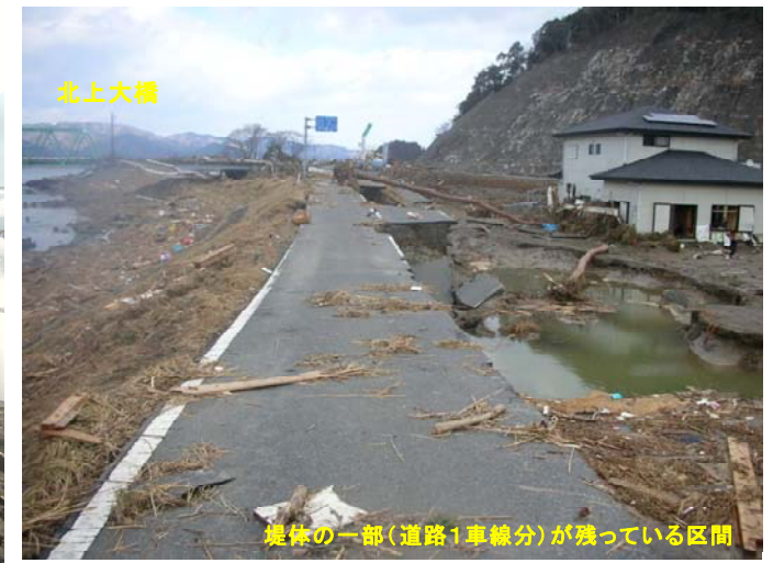
上流側より撮影
