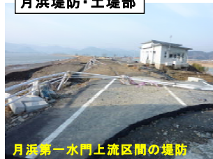
月浜第一水門上流区間の堤防
