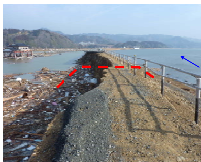
土堤部(終点側より2.6k付近・左岸)
