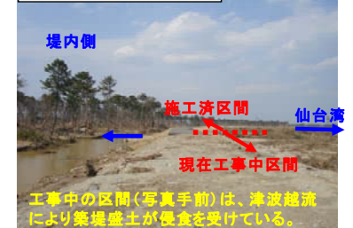
藤塚堤防(工事区間)
