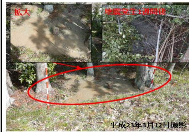
③右岸30.8k付近: 川裏のり戻り土砂流出状況 暗灰色の細砂が分布。砂は高含水である。
