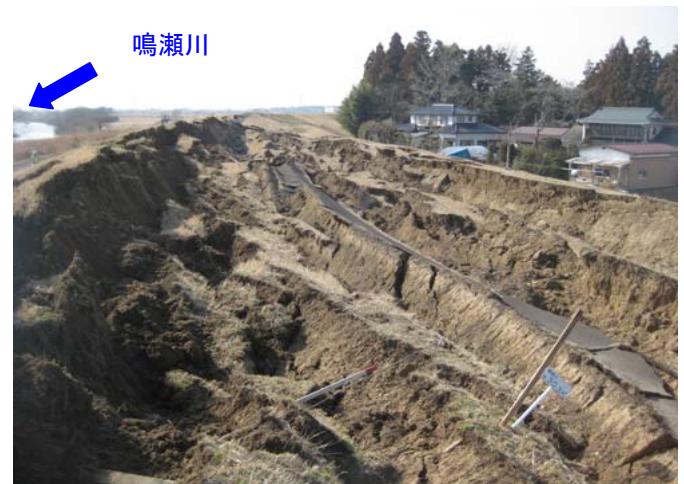
写真① 裏法は幾重にも縦断クラックが発生するとともにほらみ出しが見られる
