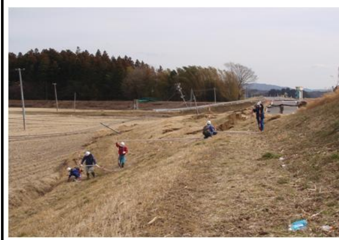
③川裏法尻状況：はらみ出し 川裏側のり尻は耕作地まで押し出される。
