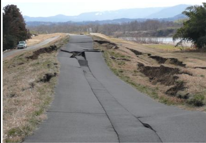
①右岸30.8k付近: 縦断クラック発生 深さは1.00m程度。
