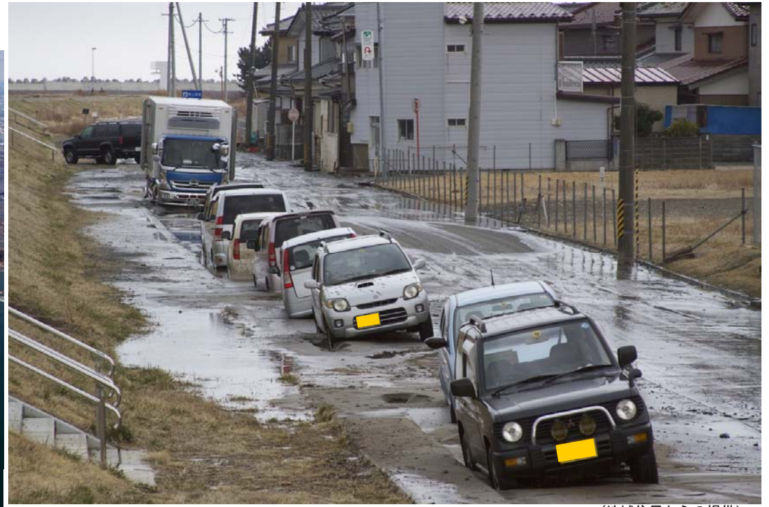
【地震直後の液状化写真】
