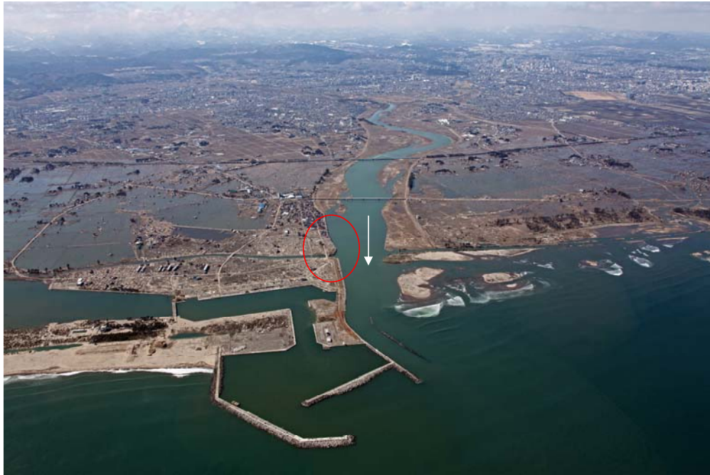
名取川河口部 液状化状況写真
