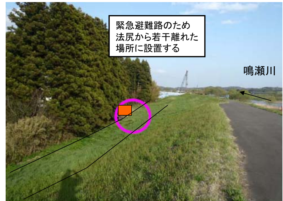
地震計設置箇所(案) 無被災箇所遠景
