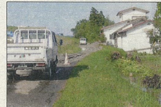
H15地震後の被災状況(民家の傾斜)
