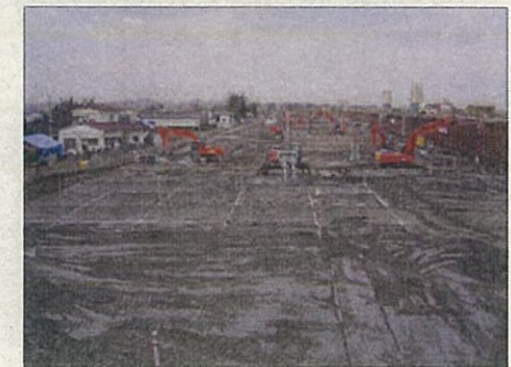
基礎改良(パワーブレンダー)
