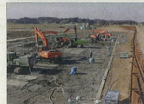
基礎改良(パワーブレンダー)
