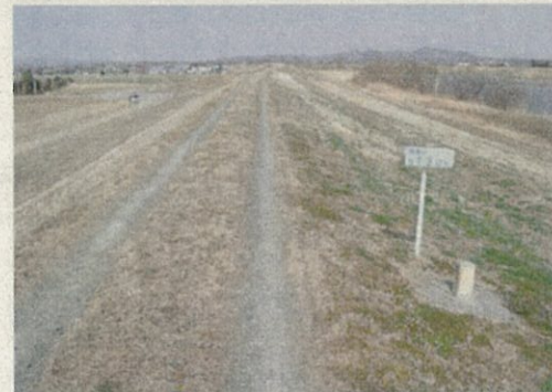
今回の地震後の状況(対策工部に変状なし)
