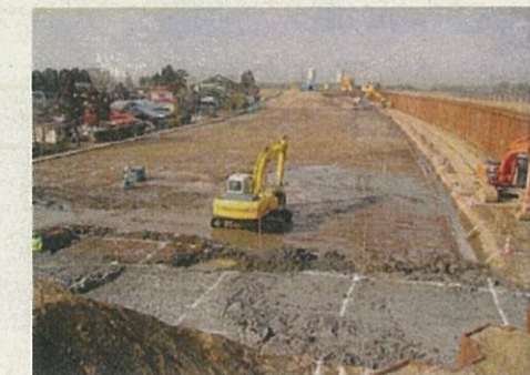
基礎改良(パワーブレンダー)
